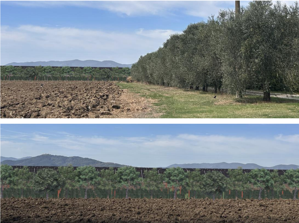
Figura 31 - Ricostruzione 3D delle aree di impianto con indicazione della presenza della fascia di mitigazione perimetrale
