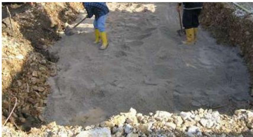
**Figura 31 – SBANCAMENTO PIANO POSA CABINE**
