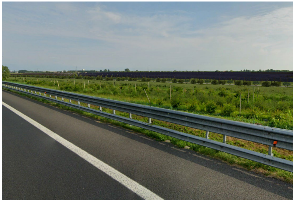
Vista da Autostrada A28
