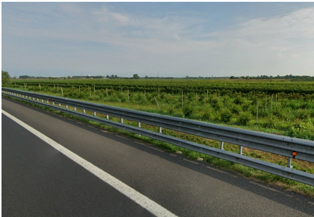
Vista da Autostrada A28
