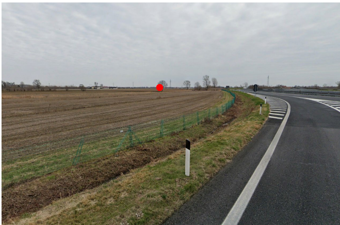
Vista svincolo A28 “Villotta”
