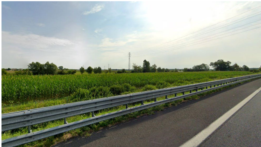
Figura 11 – Vista da Autostrada A28
