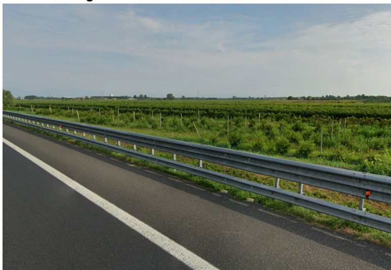
Figura 14 – Vista da Autostrada A28 - 2
