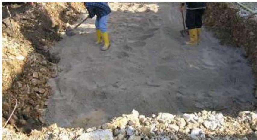
FIGURA 32 – SBANCAMENTO PIANO POSA CABINE
