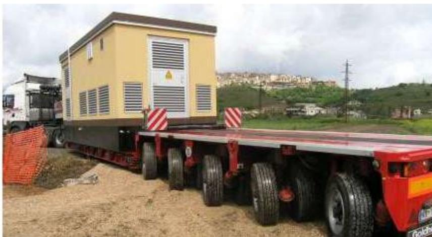
**FIGURA 34 – INSTALLAZIONE CABINE**
