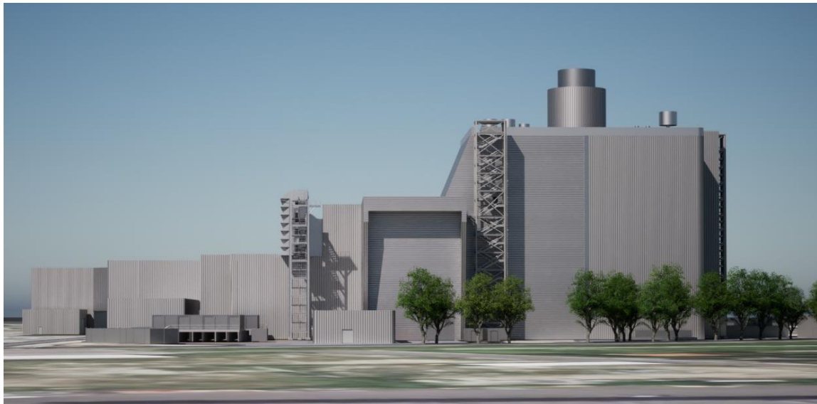
Figura 3.4f: Rendering del ciclo combinato (vista da Sud-Est) – configurazione progetto modificato oggetto della RP
