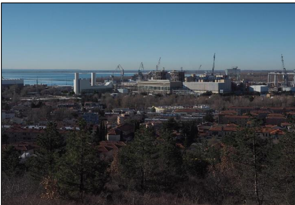
Figura 2.2.2d: Vista della Centrale nell'assetto di progetto autorizzato, dai rilievi collinari a N dell'impianto
