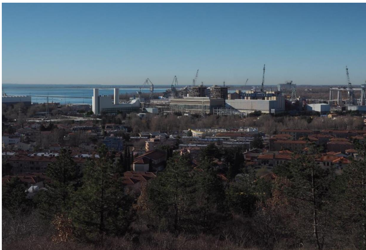
Figura 6b: Panoramica della Centrale Termoelettrica nella configurazione di progetto autorizzata dalle alture poste nella fascia orientale del territorio comunale di Monfalcone
