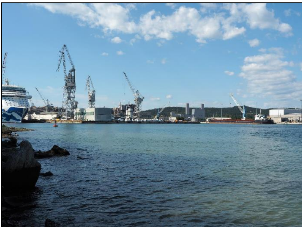
Figura 2.2.2c: Vista della Centrale nell'assetto di progetto autorizzato, dal promontorio di Panzano Bagni
