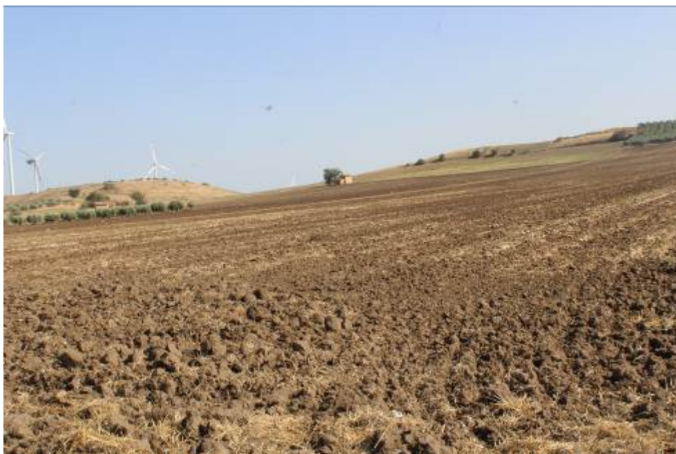
Figura 15 - Vista dei siti di realizzazione dei Campi fotovoltaici 15 e 16
