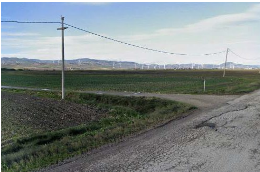
Figura 22 – Tratto della SP106 superato dal cavidotto MT
