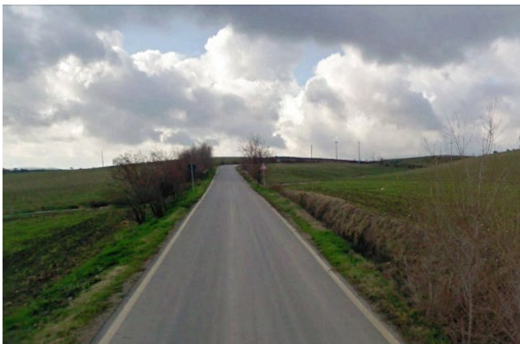
Figura 23 – Tratto della SP120 interessato dalla posa del cavidotto MT
