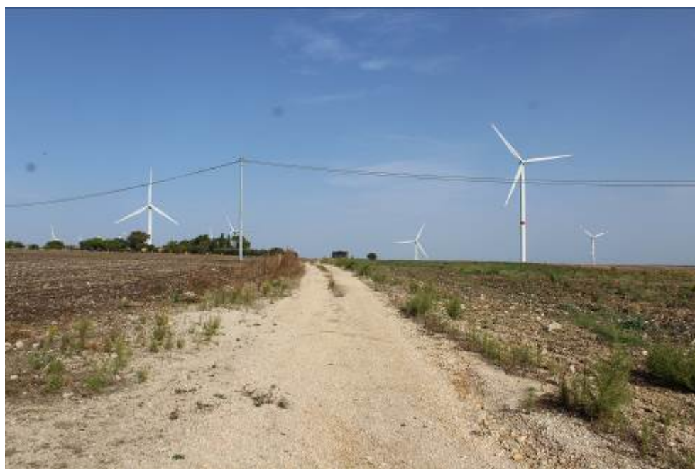
Figura 24 – Strada a servizio di un impianto eolico posta di fronte alla SE di utenza, interessato a dalla posa del cavidotto MT
