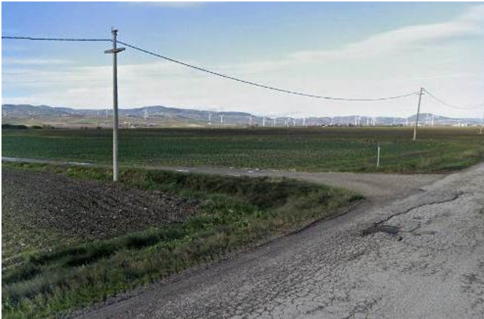
Figura 19 – Tratto della SP106 superato dal cavidotto MT
