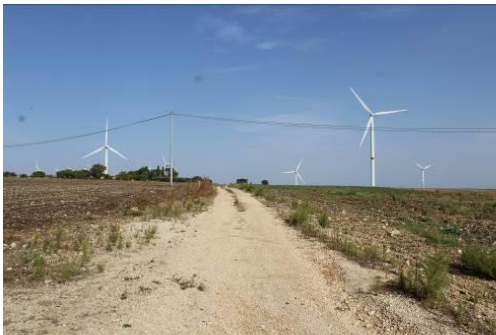
Figura 21 – Strada a servizio di un impianto eolico posta di fronte alla SE di utenza, interessato a dalla posa del cavidotto MT
