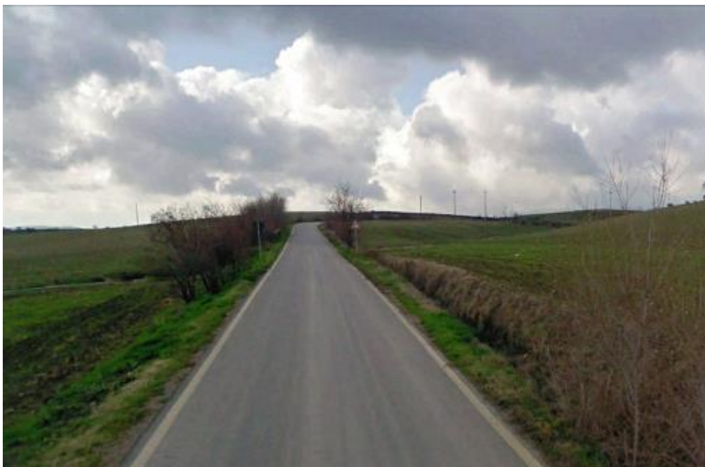
Figura 20 – Tratto della SP120 interessato dalla posa del cavidotto MT
