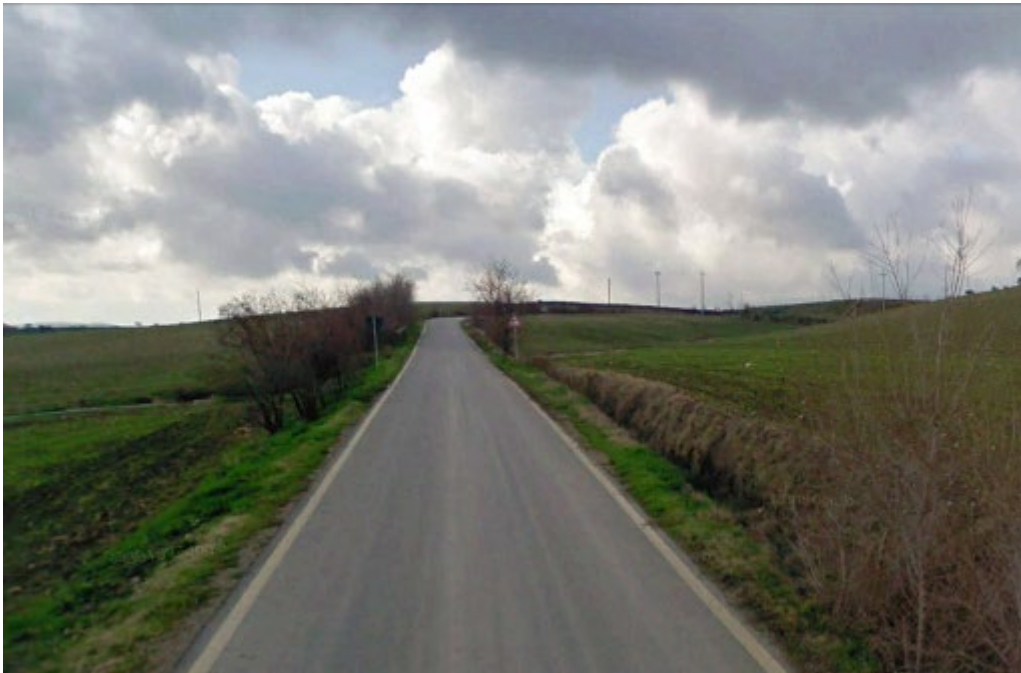
Figura 21 – Tratto della SP120 interessato dalla posa del cavidotto MT
