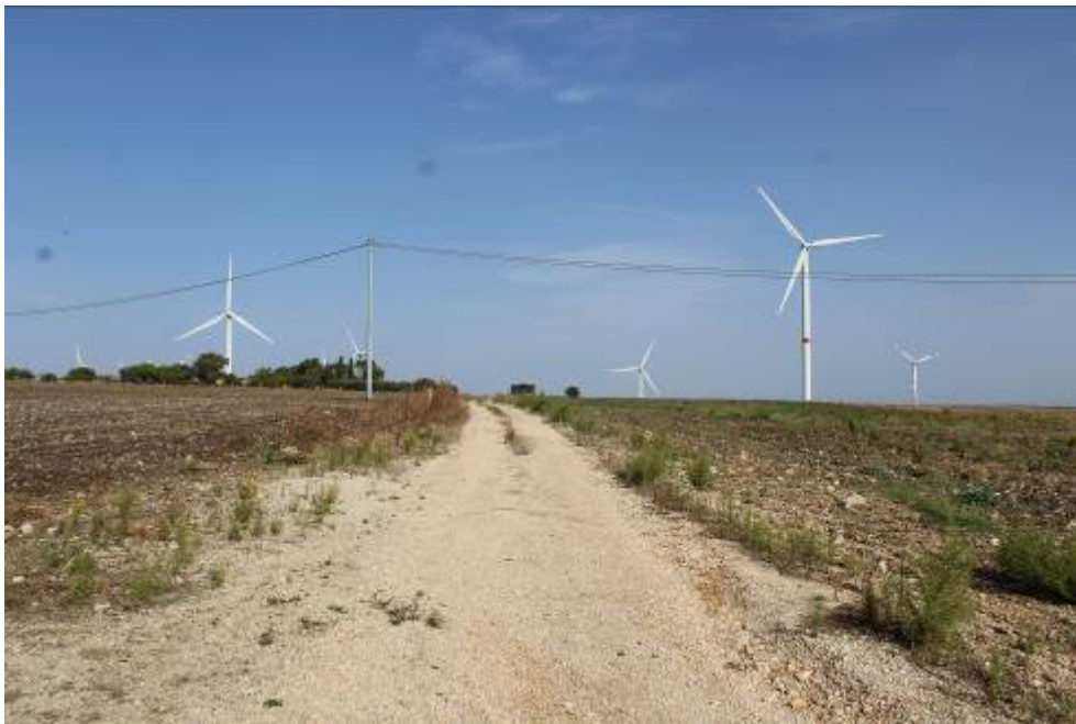
Figura 22 – Strada a servizio di un impianto eolico posta di fronte alla SE di utenza, interessato a dalla posa del cavidotto MT
