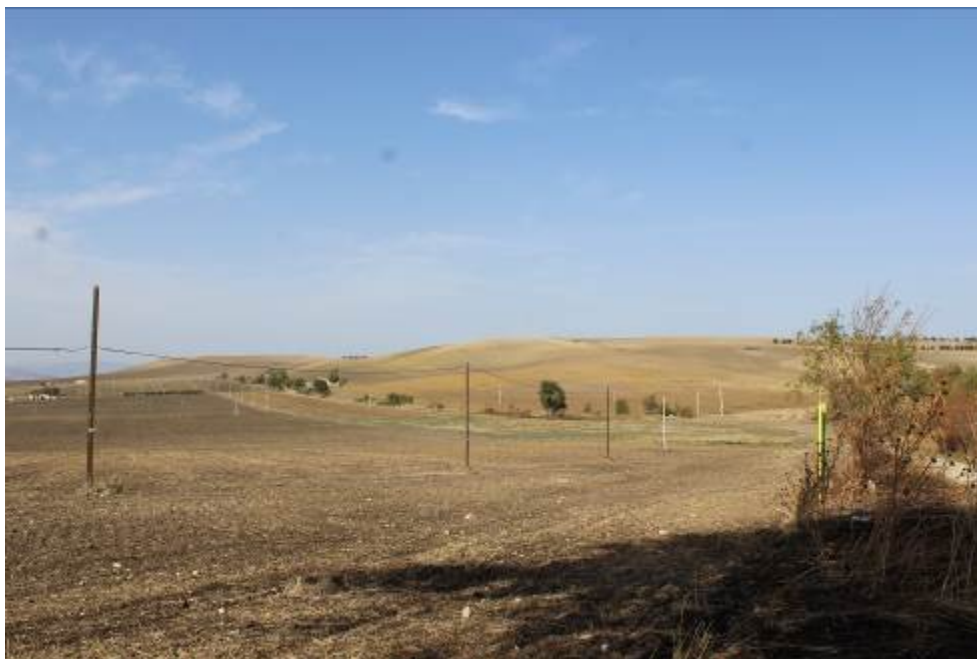
Figura 11 - Vista dei siti di realizzazione dei Campi fotovoltaici 12 e 13
