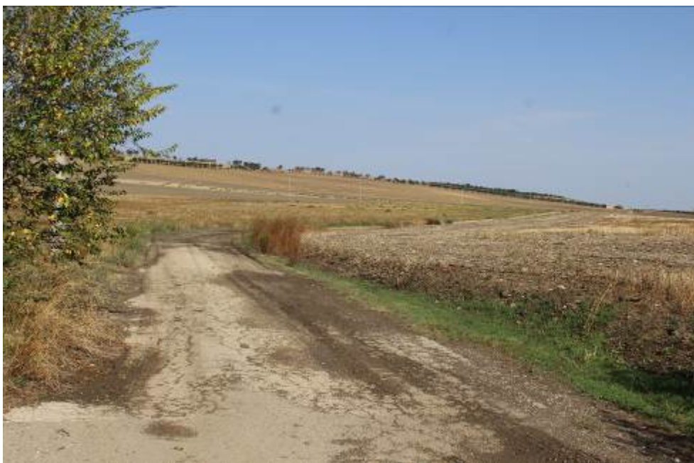
Figura 10 - Vista dei siti di realizzazione dei Campi fotovoltaici 10 e 11
