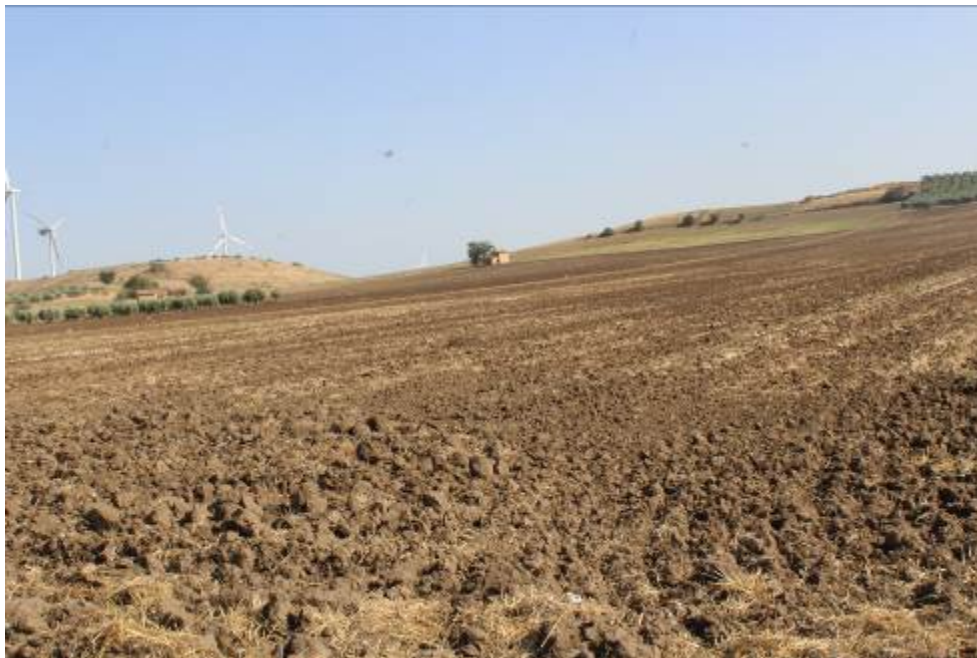
Figura 13 - Vista dei siti di realizzazione dei Campi fotovoltaici 15 e 16
