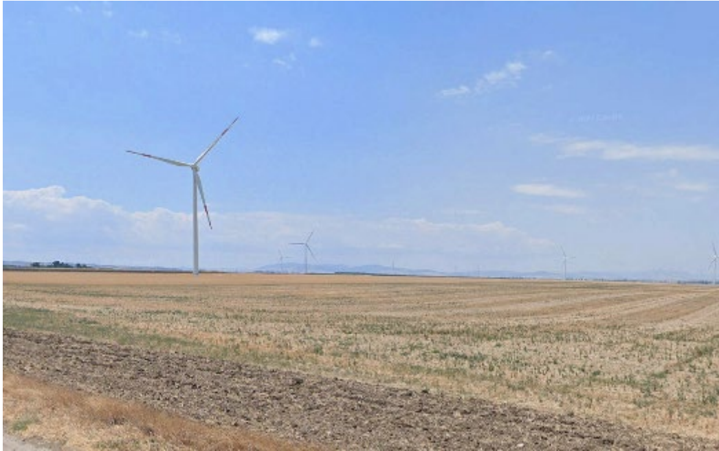
Figura 19 - Vista dei siti di realizzazione dei Campi fotovoltaici 23 e 24
