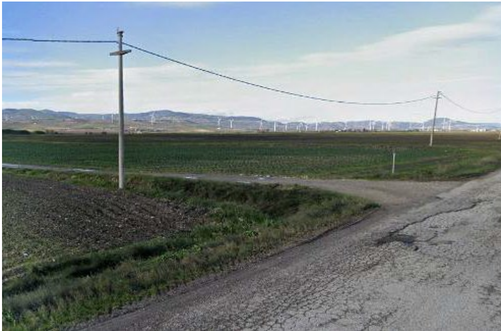
Figura 20 – Tratto della SP106 superato dal cavidotto MT
