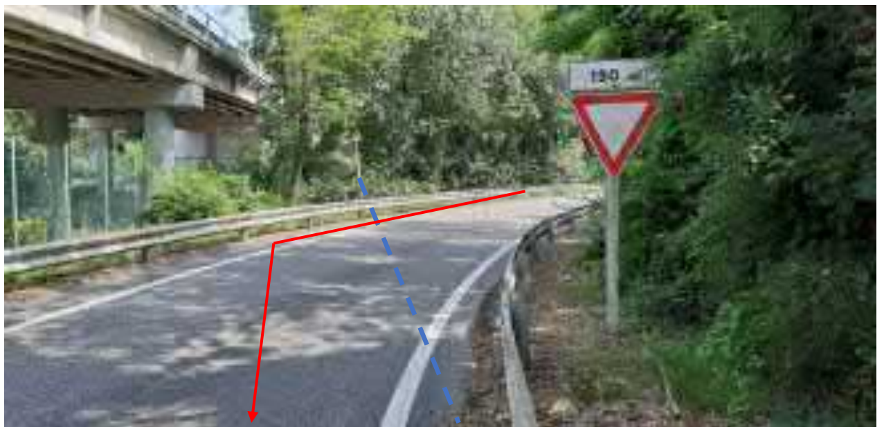
FOTO N.9 – Vista contro senso gas Inizio percorrenza strada comunale di Raccordo stradale SS n.14
