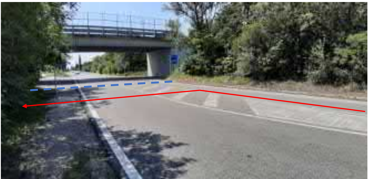
FOTO N.7 –Attraversamento SS n.14 (tratto di competenza regionale-SR)
