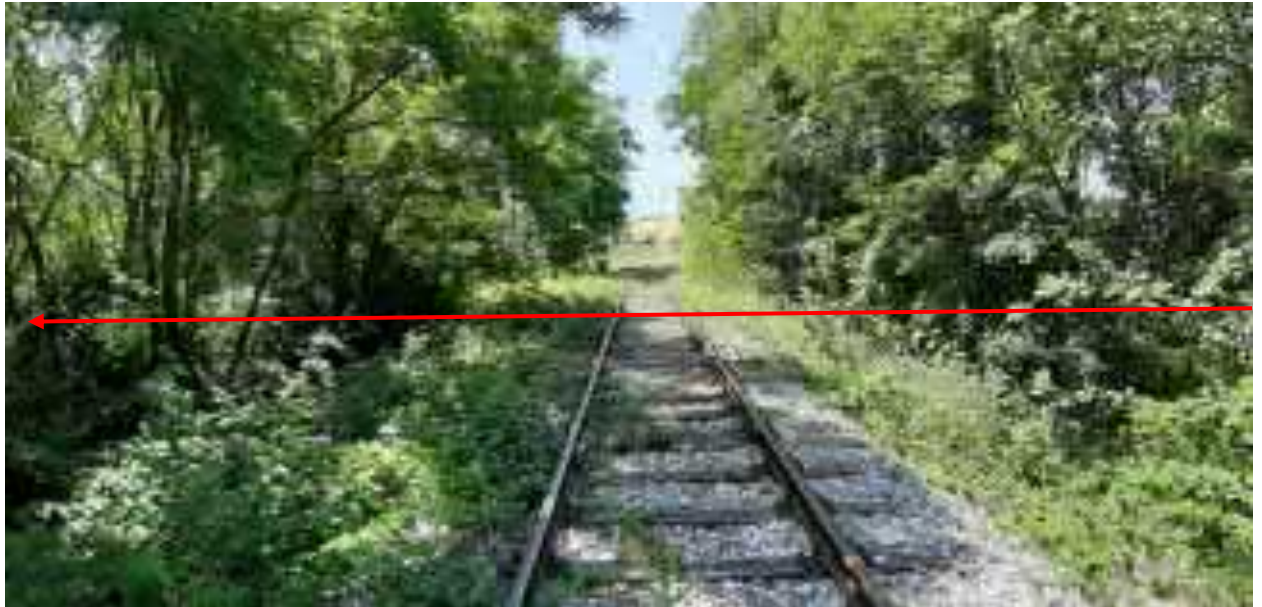
FOTO N.16 – Attraversamento Raccordo ferroviario base All. Cartiera Burgo
