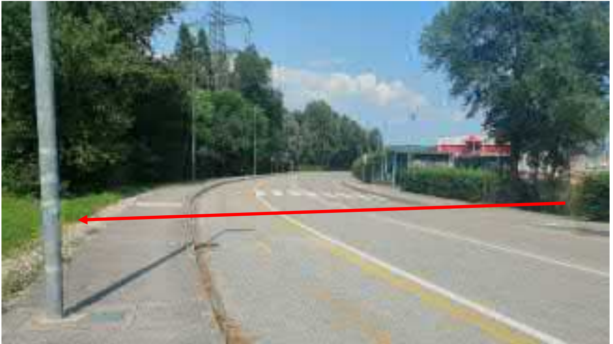
FOTO N.29 – Panoramica dell’attraversamento via Consiglio d’Europa e raccordo ferroviario base del Lisert (II attraversamento) mediante unica trivellazione
