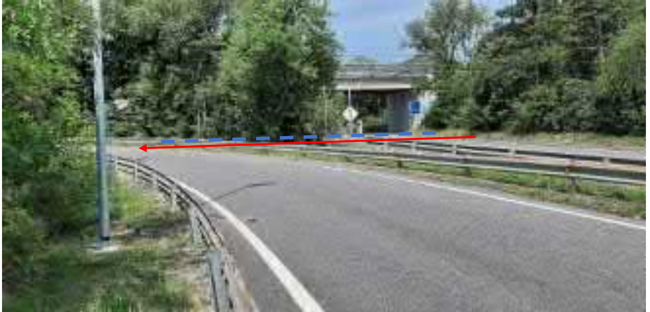
FOTO N.8 – Panoramica Inizio percorrenza strada comunale di Raccordo stradale SS n.14
