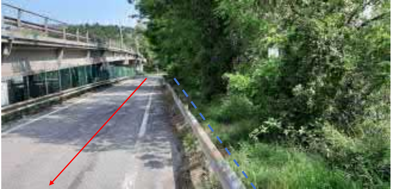
FOTO N.10 – Vista contro senso gas percorrenza strada comunale di Raccordo stradale SS n.14 e parallelismo met. SNAM esistente
