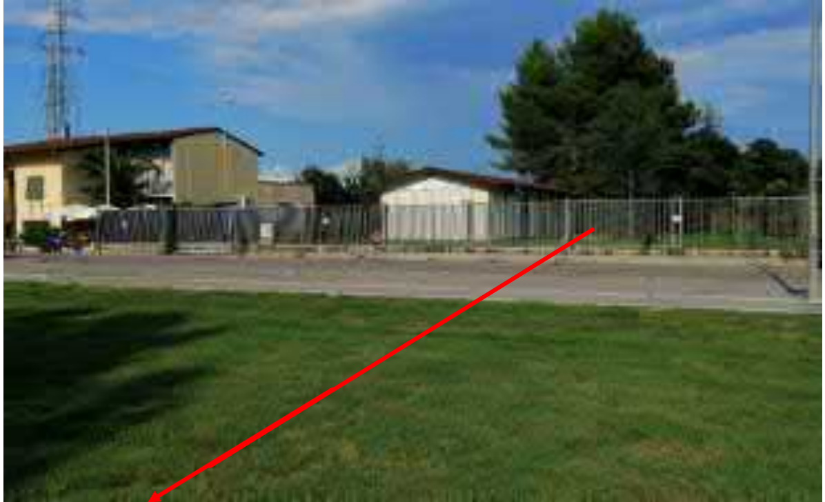
FOTO N.35 – Vista contro senso gas attraversamento Strada comunale via Timavo
