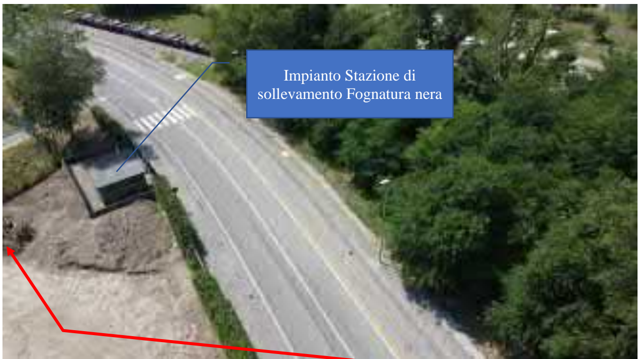
FOTO N.26a – Panoramica fine percorrenza via Consiglio d’Europa attraversamento area privata (vista senso gas)
