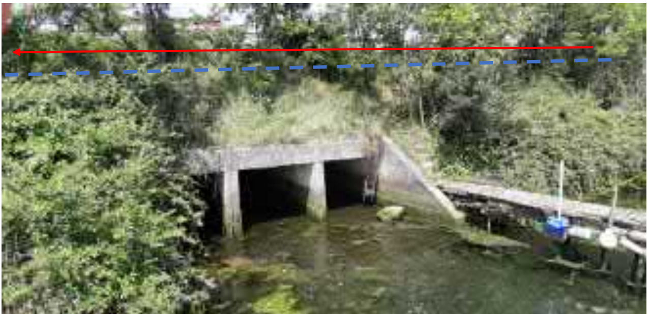
FOTO N.11 – Attraversamento del canale interrato in C.A. in sovrappasso con scavo a cielo aperto sotto strada
