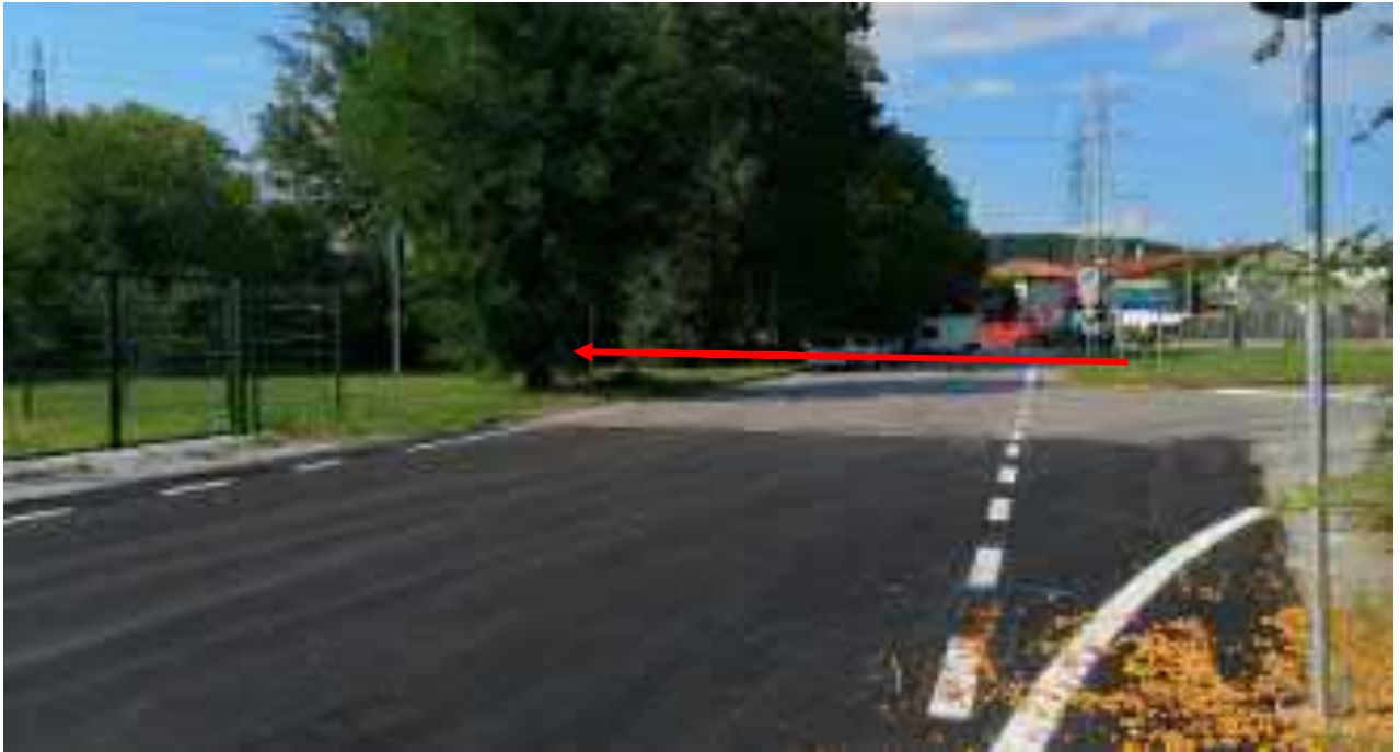
FOTO N.37 – Attraversamento Strada comunale Via V. Veneto
