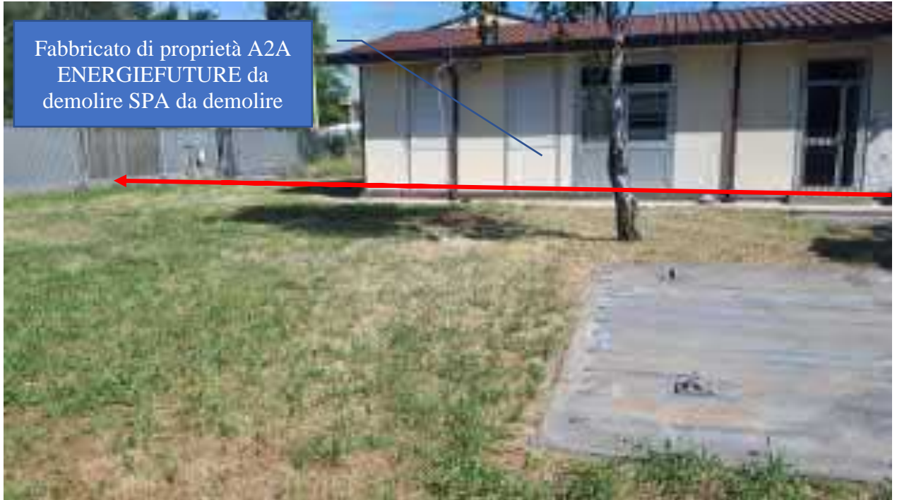
FOTO N.33 – Percorrenza area di proprietà A2A ENERGIEFUTURE SPA in stretto parallelismo al canale di scarico in CA della centrale
