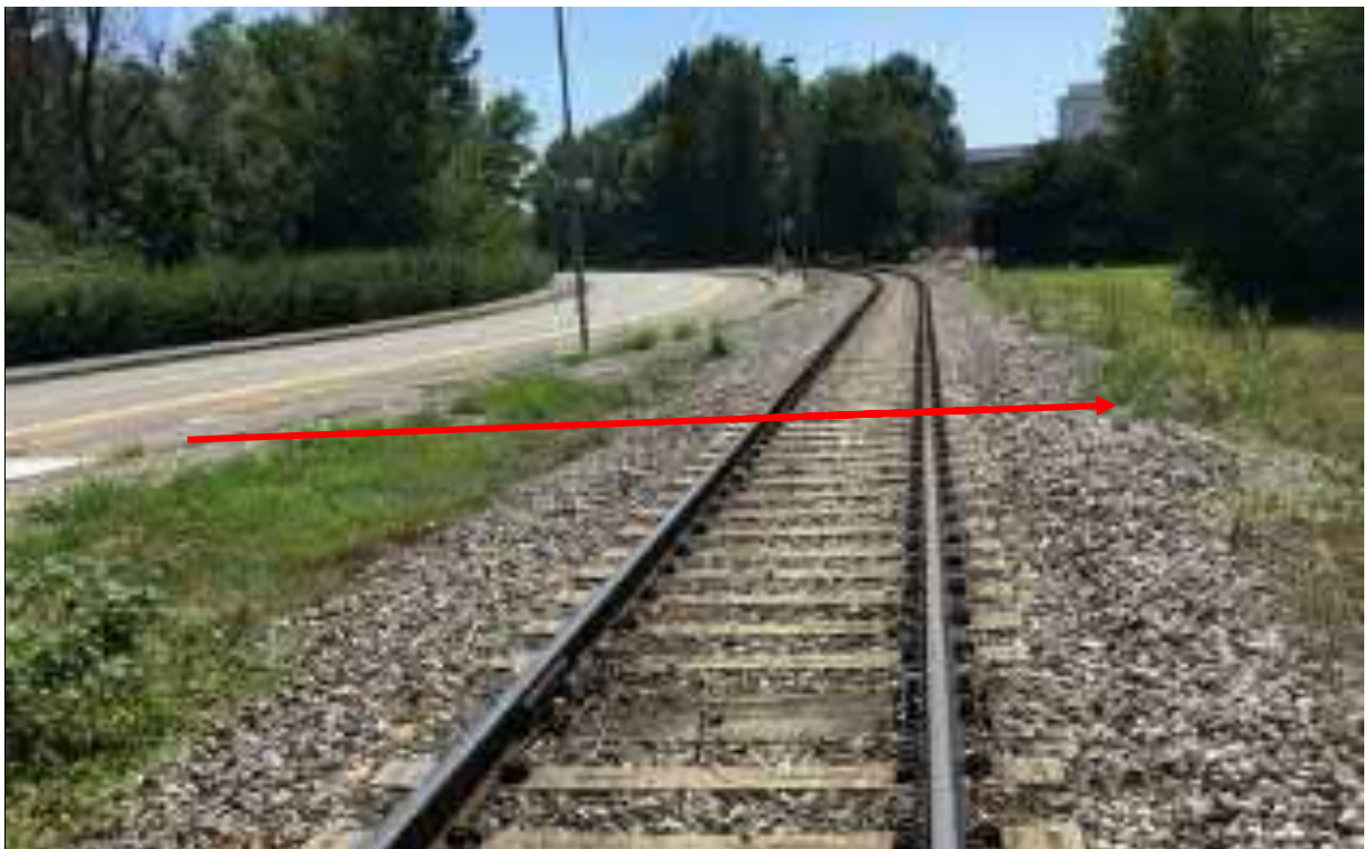
FOTO N.30 – Attraversamento raccordo ferroviario base del Lisert (2° attraversamento)
