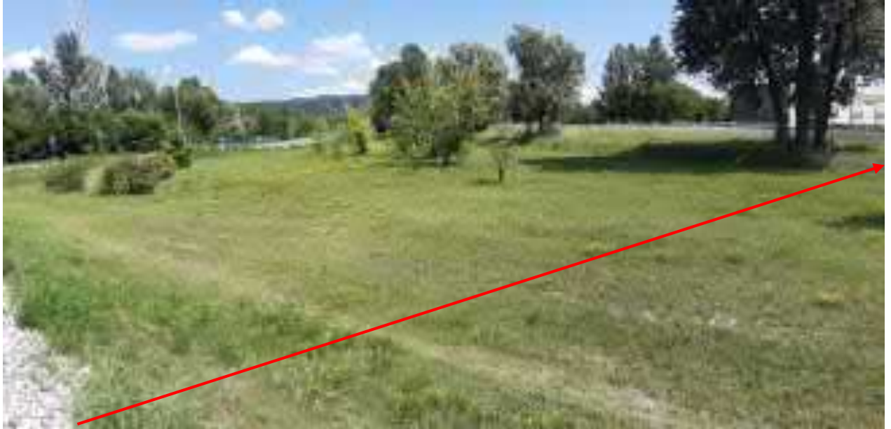
FOTO N.18 – Panoramica a monte del 1° attraversamento Raccordo ferroviario base del Lisert (vista senso gas)
