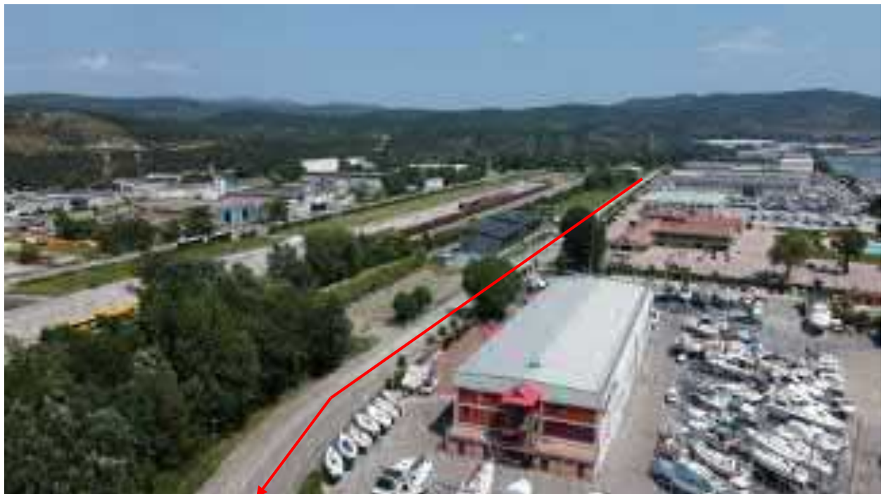
FOTO N.23 – Panoramica percorrenza strada Via Consiglio d'Europa (vista contro senso gas)
