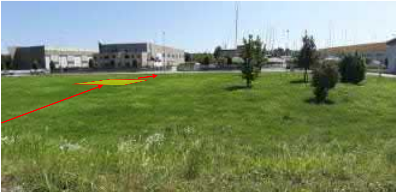
FOTO N.20 – Panoramica a valle del 1° attraversamento Raccordo ferroviario base del Lisert e vista area impianto PIL n.2 (vista senso gas)
