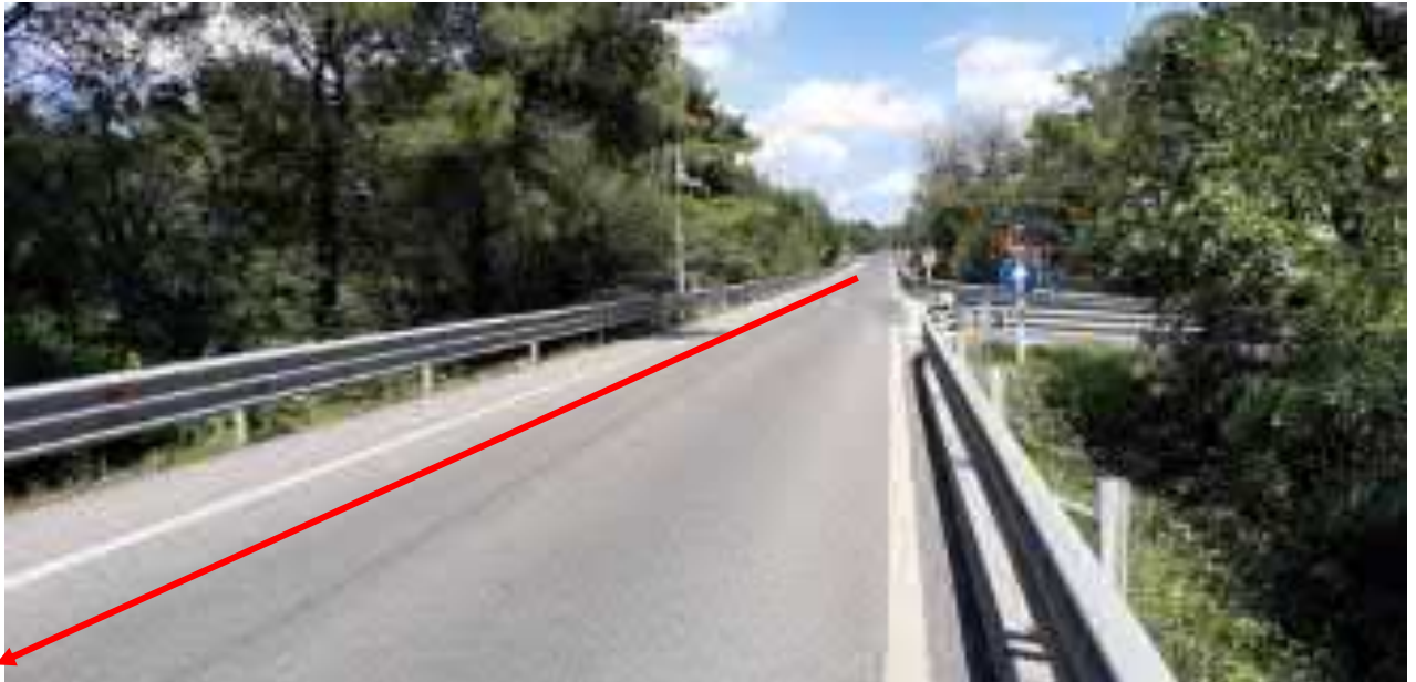
FOTO N.4 – Vista contro senso gas Percorrenza Strada Statale SS n.14/55r “Raccordo della Venezia Giulia”
