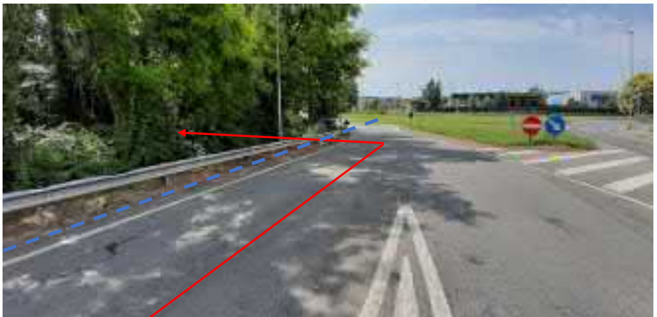
FOTO N.13 – vista contro senso gas Fine percorrenza strada comunale di Raccordo stradale SS n.14 e parallelismo met. SNAM esistente
