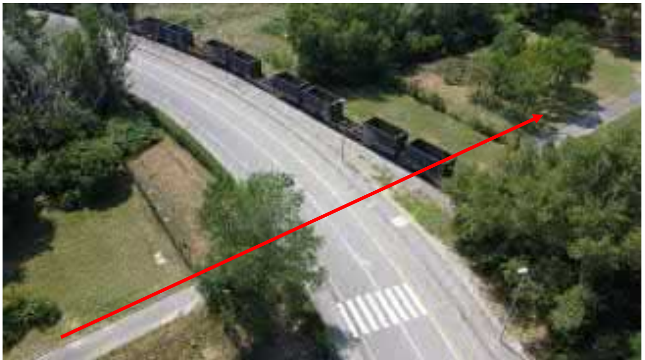
FOTO N.28 – Panoramica dell’attraversamento via Consiglio d’Europa e raccordo ferroviario base del Lisert (II attraversamento) mediante unica trivellazione
