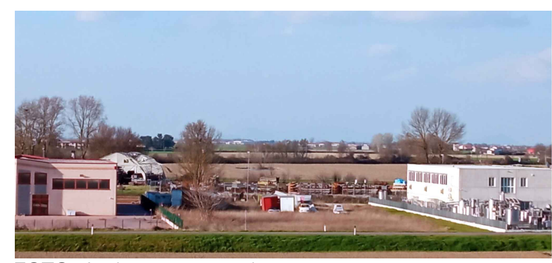
FOTO Argine veneto sud
