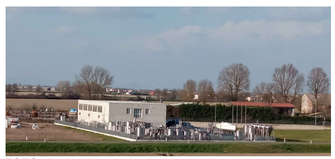
FOTO Argine veneto sud
