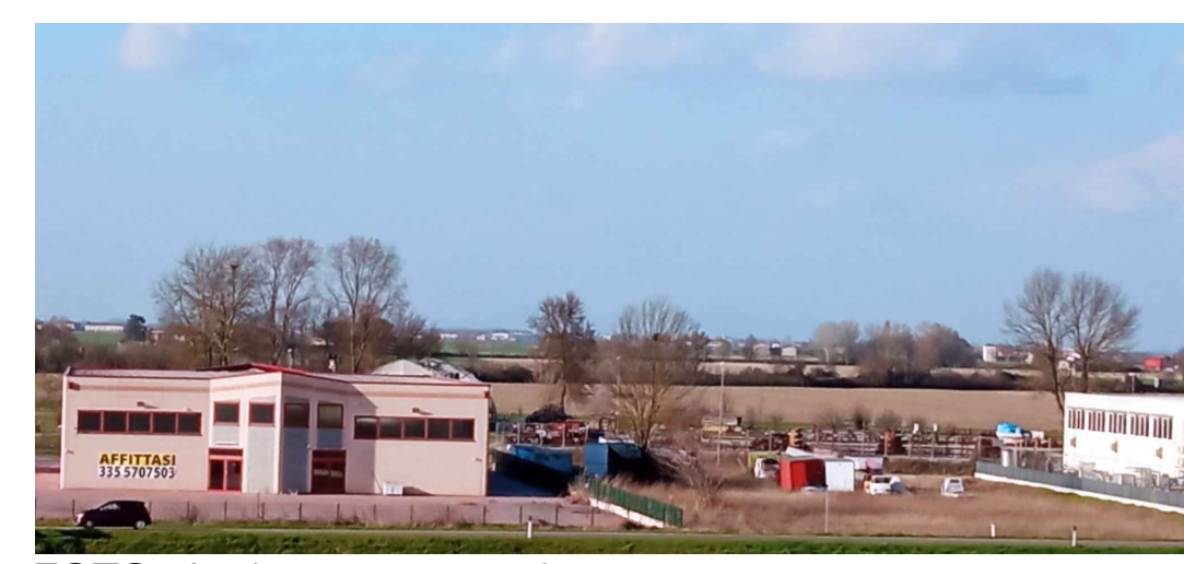
FOTO Argine veneto sud
