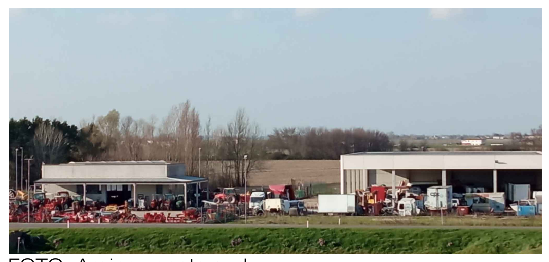
FOTO Argine veneto sud
