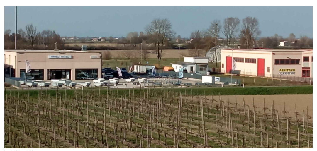
FOTO argine veneto sud
