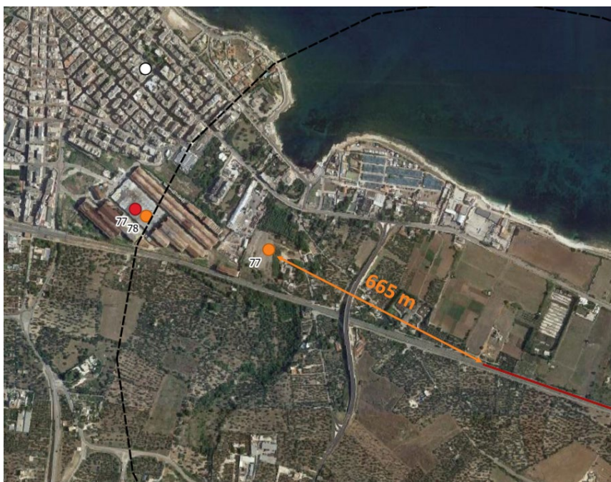
Figura 6-2 Localizzazione dei siti relativi allo stabilimento AFP rispetto al tracciato ferroviario e relativa distanza dal sito più prossimo
