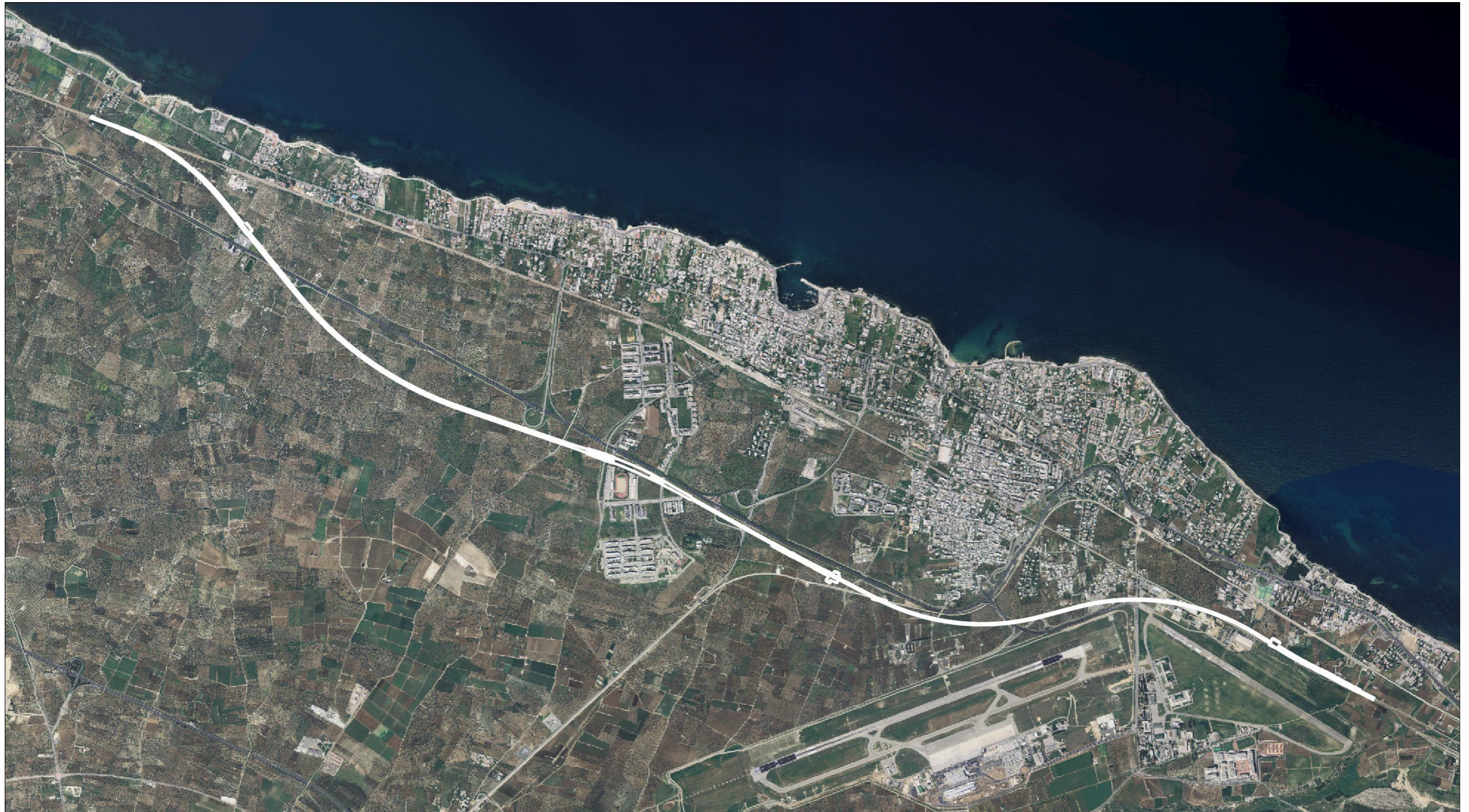
Figura 3-2 Vista aerea dell'area interessata dal progetto: Annualità 2006
