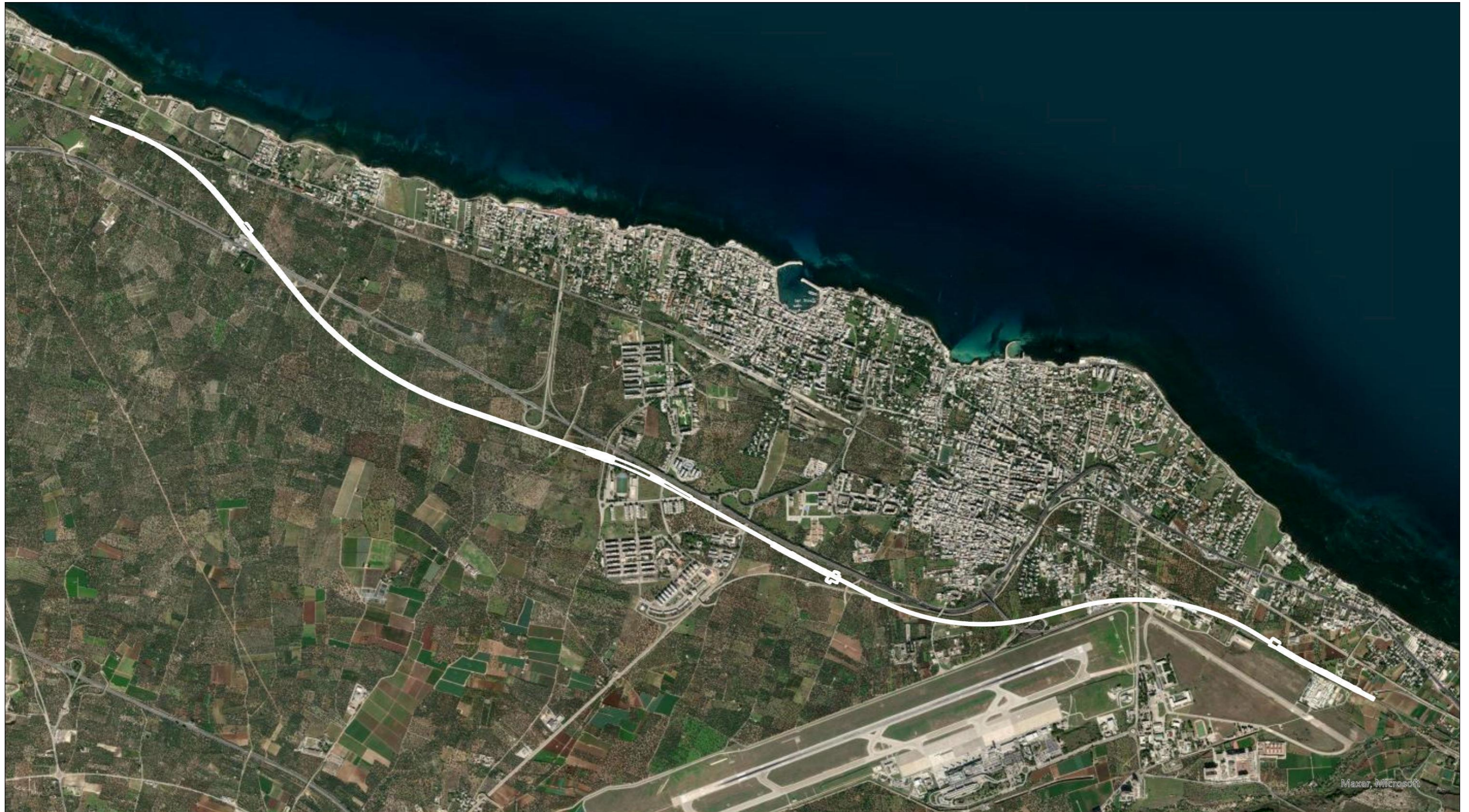
Figura 3-3 Vista aerea dell'area interessata dal progetto: Annualità 2022
