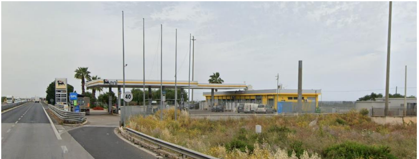
Figura 3-6 Area di servizio ENI: Carreggiata Nord
