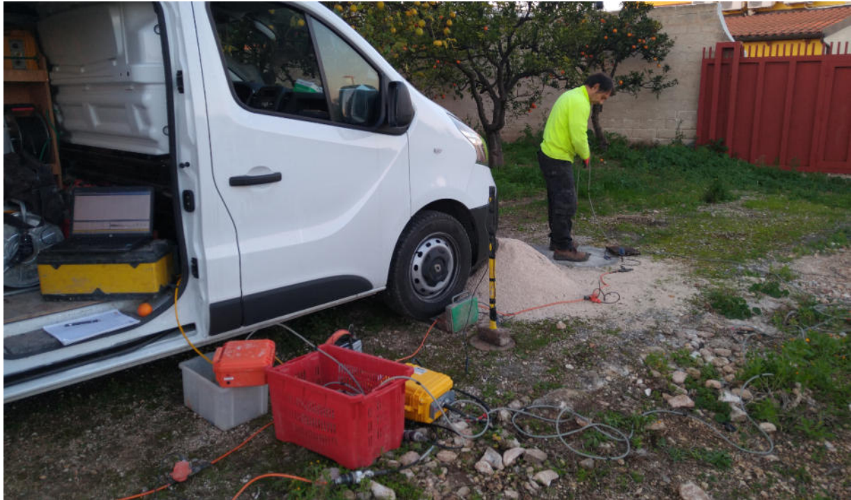
Particolare indagini in foro Down Hole GA05
