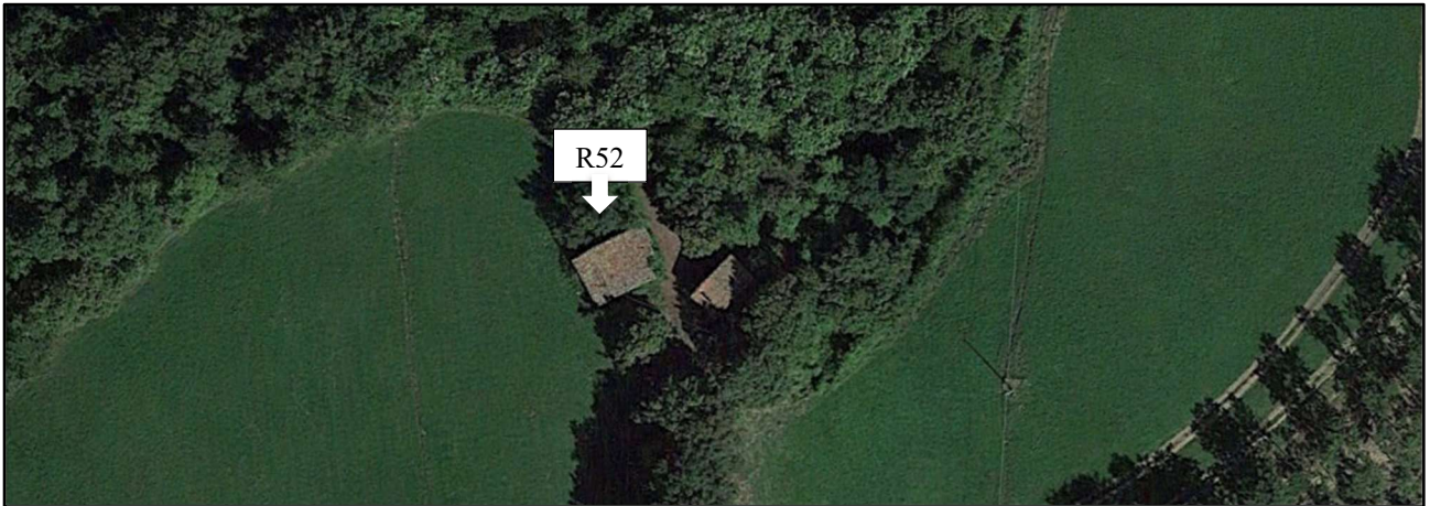
Foto 42a: R52-Non Abitazione (Foto da google earth, durante il sopralluogo non è stato possibile raggiungere tale ricettore perché localizzato in un'area non accessibile)
