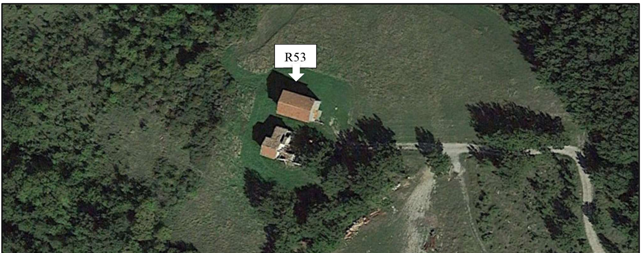
Foto 43a: R53-Non Abitazione (Foto da google earth, durante il sopralluogo non è stato possibile raggiungere tale ricettore perché localizzato in un'area non accessibile)
