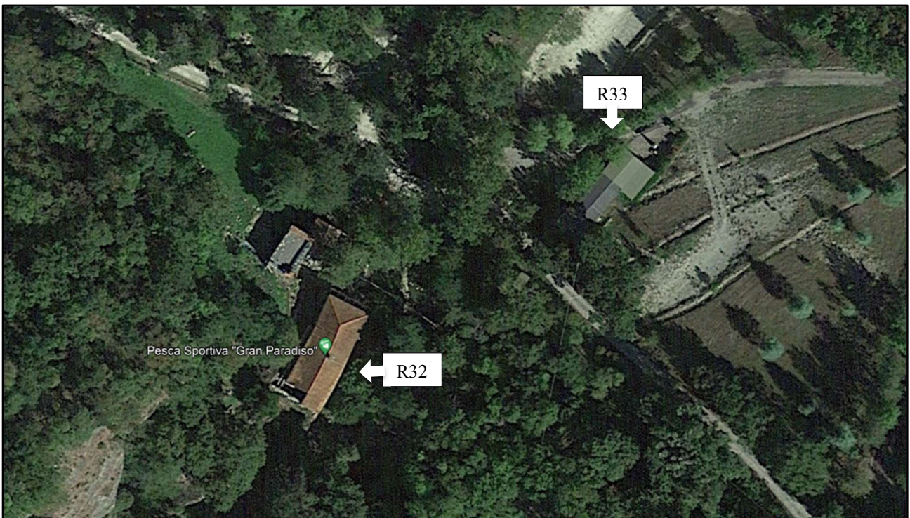
Foto 30a: R32-Abitazione; R33-Non Abitazione (Foto da google earth, durante il sopralluogo non è stato possibile raggiungere tali ricettori perché localizzati in un'area non accessibile)
