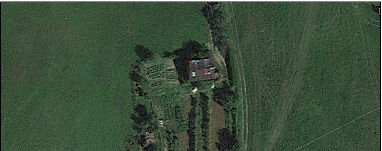
Foto 51a: R65-Non Abitazione (Foto da google earth, durante il sopralluogo non è stato possibile raggiungere tale ricettore perché localizzato in un'area non accessibile)
