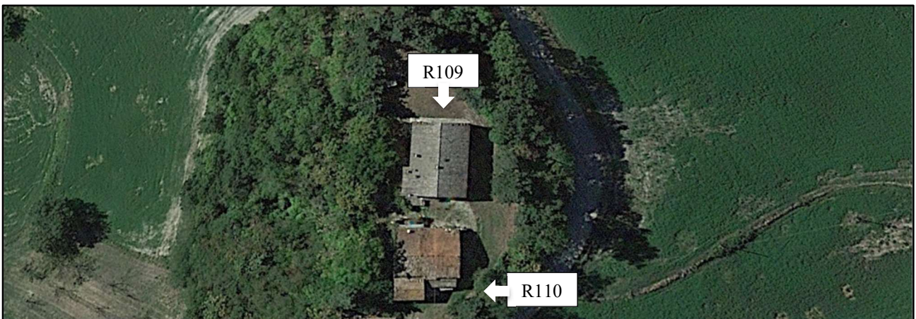
Foto 83a: R109-Non Abitazione; R110-Abitazione (Foto da google earth, durante il sopralluogo non è stato possibile raggiungere tali ricettori perché localizzati in un'area non accessibile)
