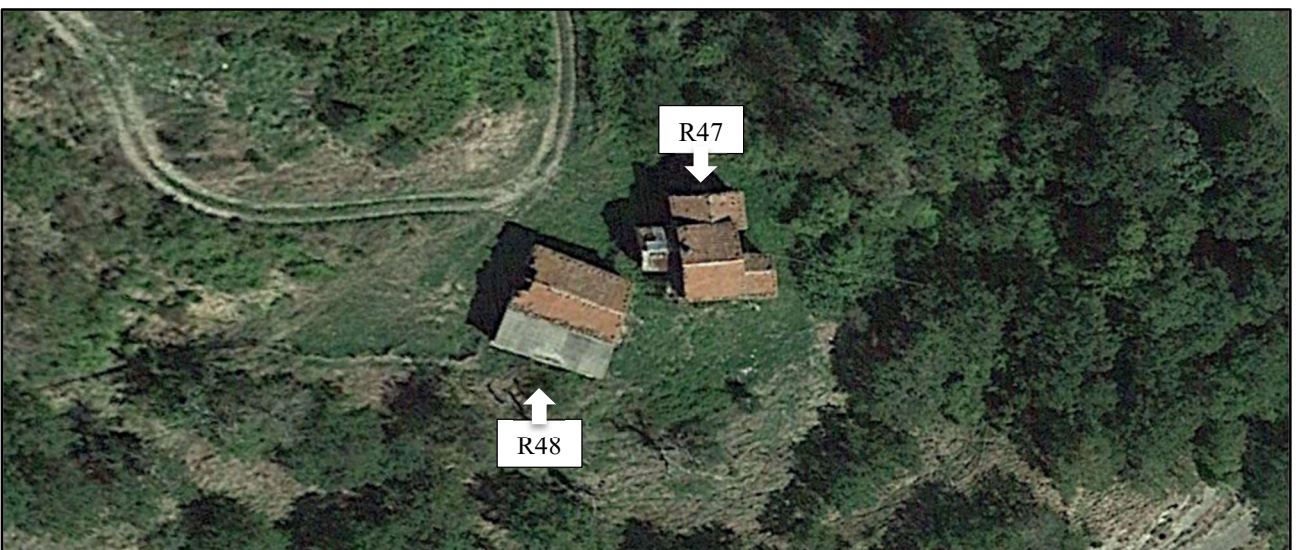
Foto 38a: R47-Non Abitazione; R48-Fabbricato Diruto (Foto da google earth, durante il sopralluogo non è stato possibile raggiungere tali ricettori perché localizzati in un'area non accessibile)
