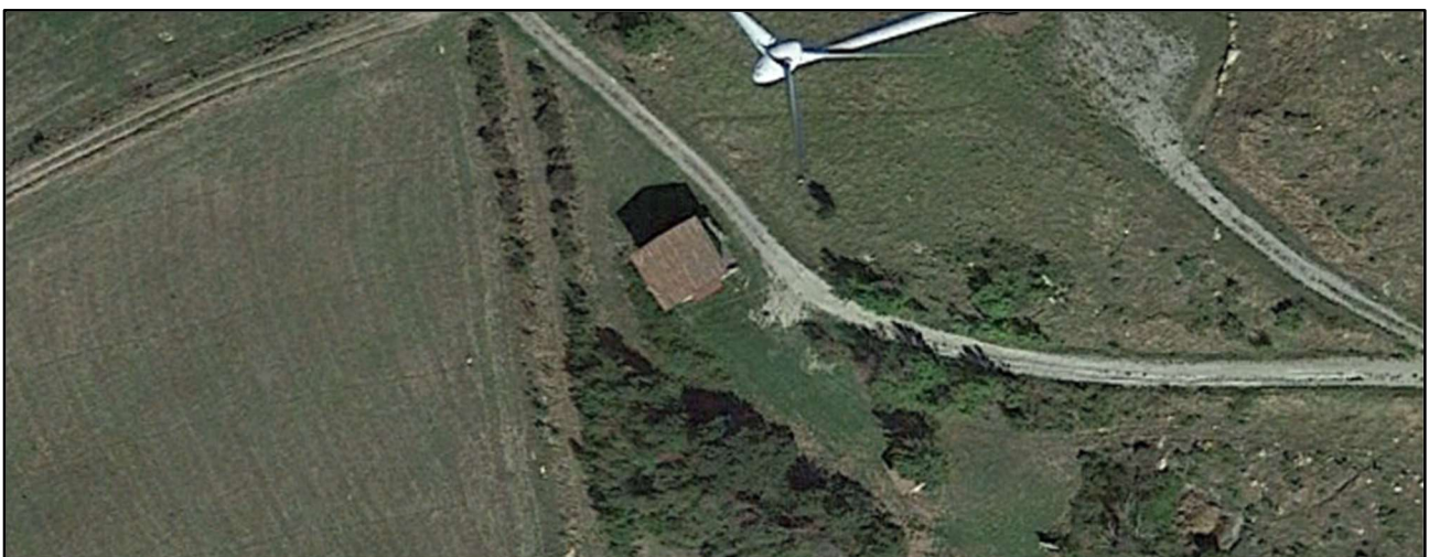
Foto 47a: R58-Non Abitazione (Foto da google earth, durante il sopralluogo non è stato possibile raggiungere tale ricettore perché localizzato in un'area non accessibile)
