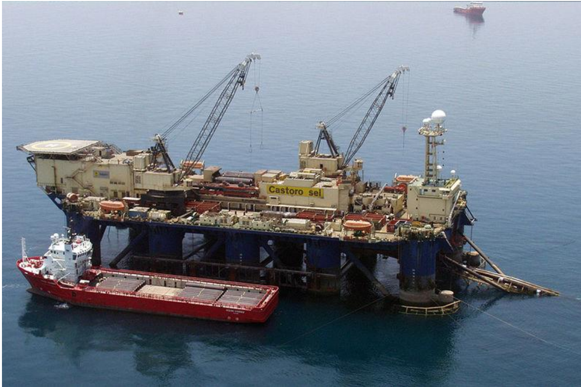
Figura 5-3: Vessel utilizzato per le operazioni di disinstallazione delle tubazioni interrato
