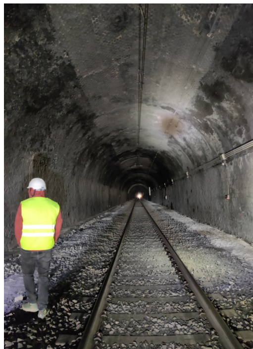
Figura 141 Galleria ferroviaria esistente - Sopralluogo
