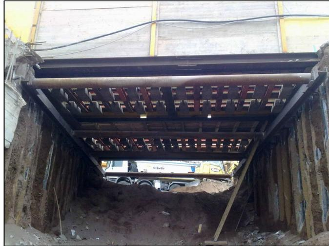
*Figure 17 Esempio scavo tra paratie per spinta a vuoto*
