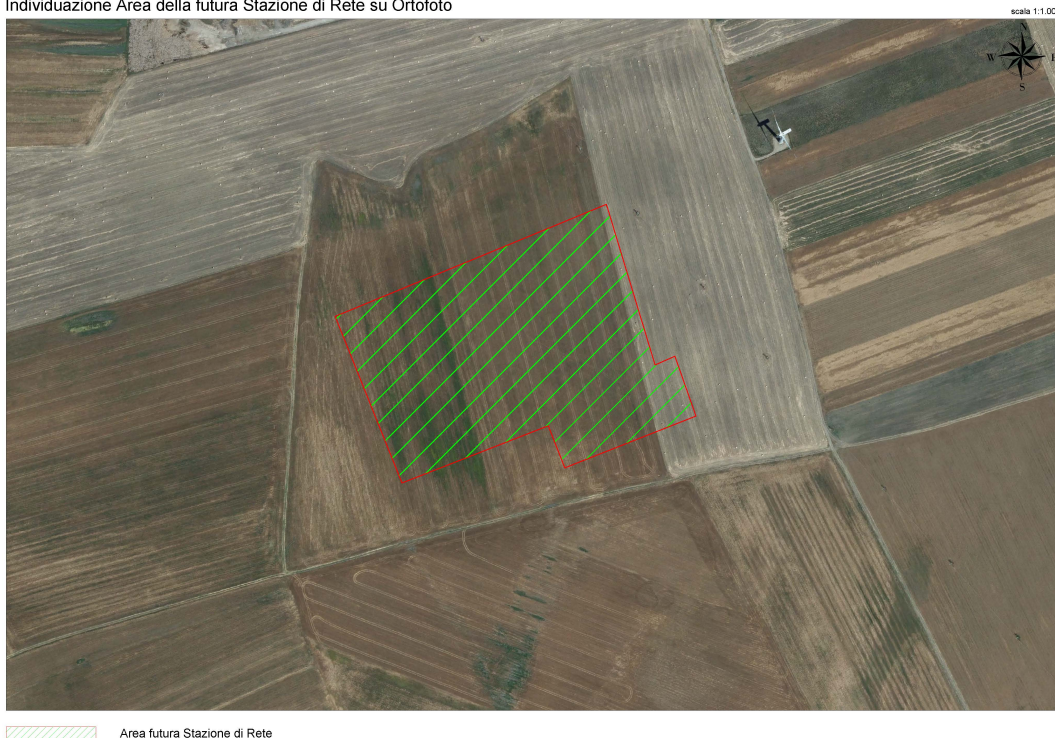
Figura 3 - Ortofoto dell'area del punto di connessione ricadente sul territorio di Sant'Agata di Puglia (FG)
