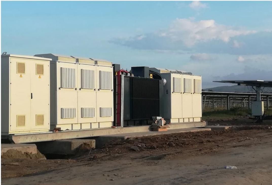
*Figura 12 - Esempio skid esterno per Convertitore di Potenza*
