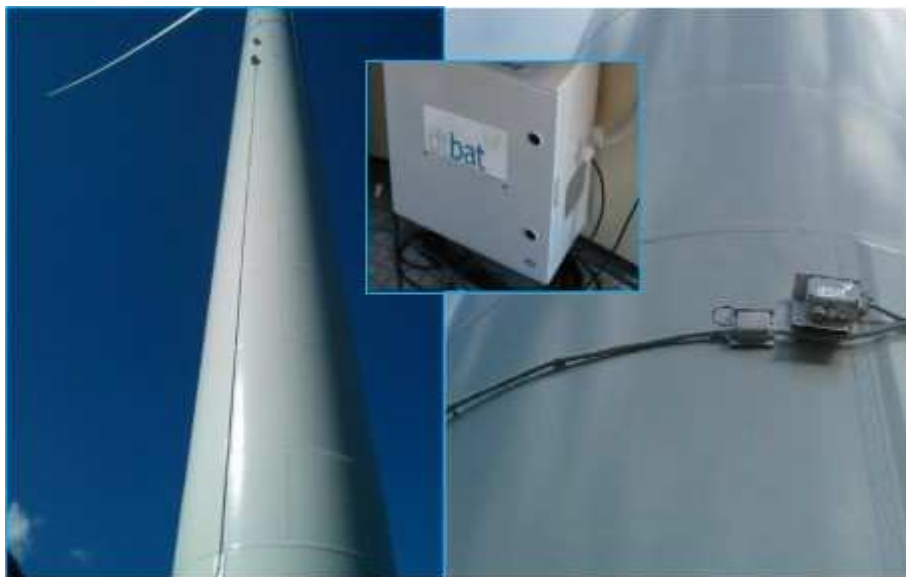
Figura 7 – Esempio di installazione di un sistema automatico su aerogeneratore per abbassare il rischio collisione
