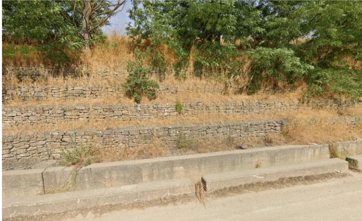
Figura 7.17 – opera di sostegno in gabbioni a monte della Strada vicinale Isca di Cozza alla base del pendio
