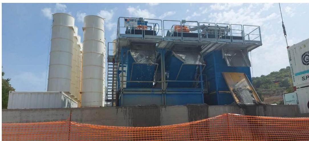
Figura 5b - Impianto di realizzazione dei diaframmi con idrofresa
