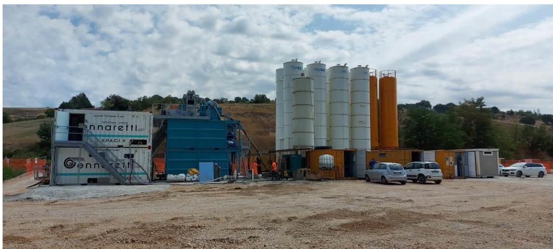
Figura 5a - Impianto di realizzazione dei diaframmi con idrofresa
