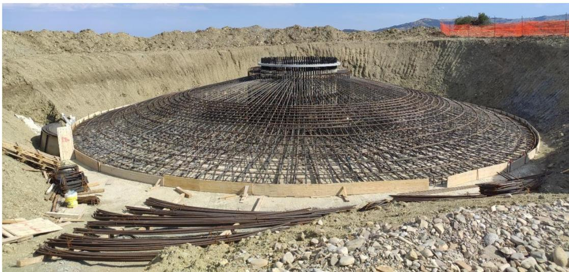
**Figura 3-3: armatura plinto tipo**
