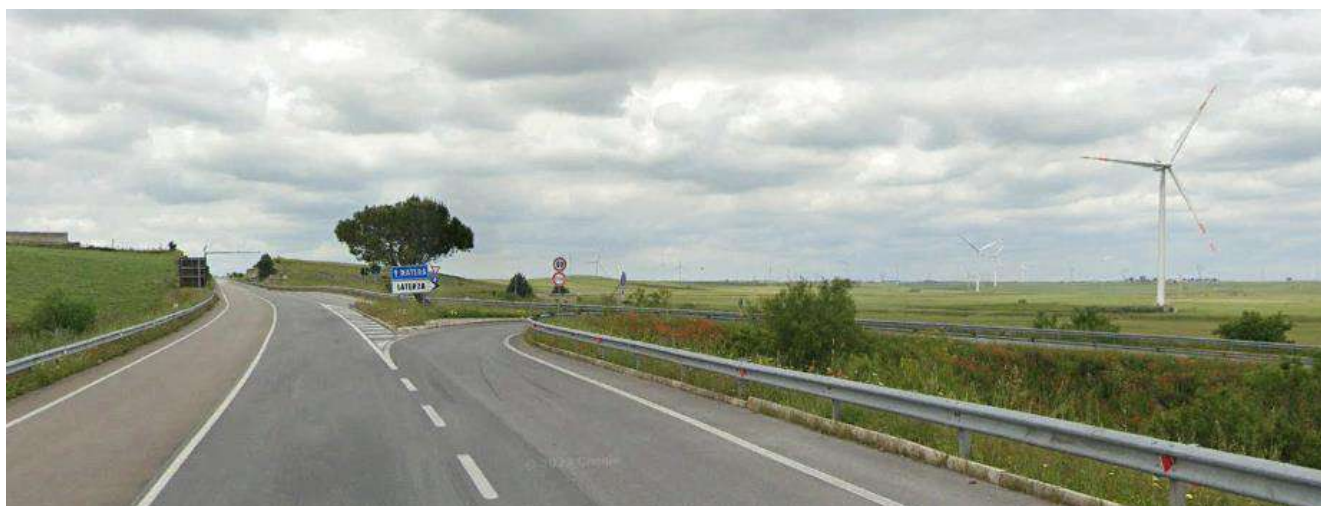
Figura 4-35: Percorso trasporto componenti delle turbine – SS7
