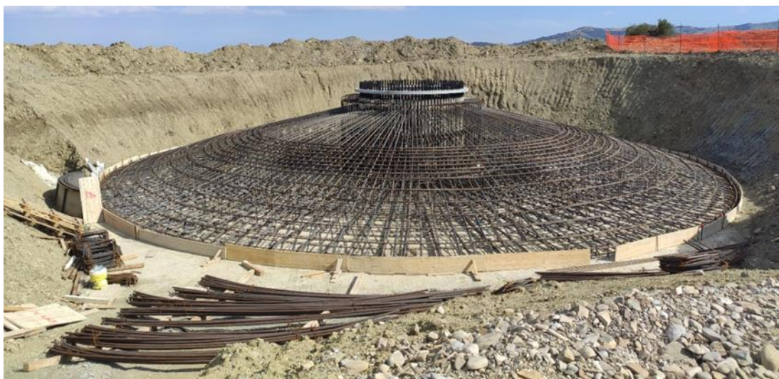
Figura 5-4: immagine tipo armature plinto
