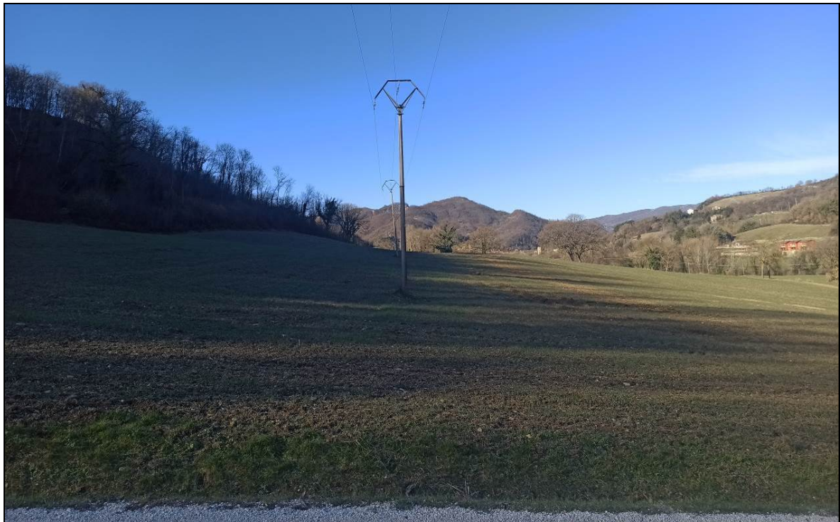
Figura 6-6 Panoramica da fianco destro del fenomeno CO2
