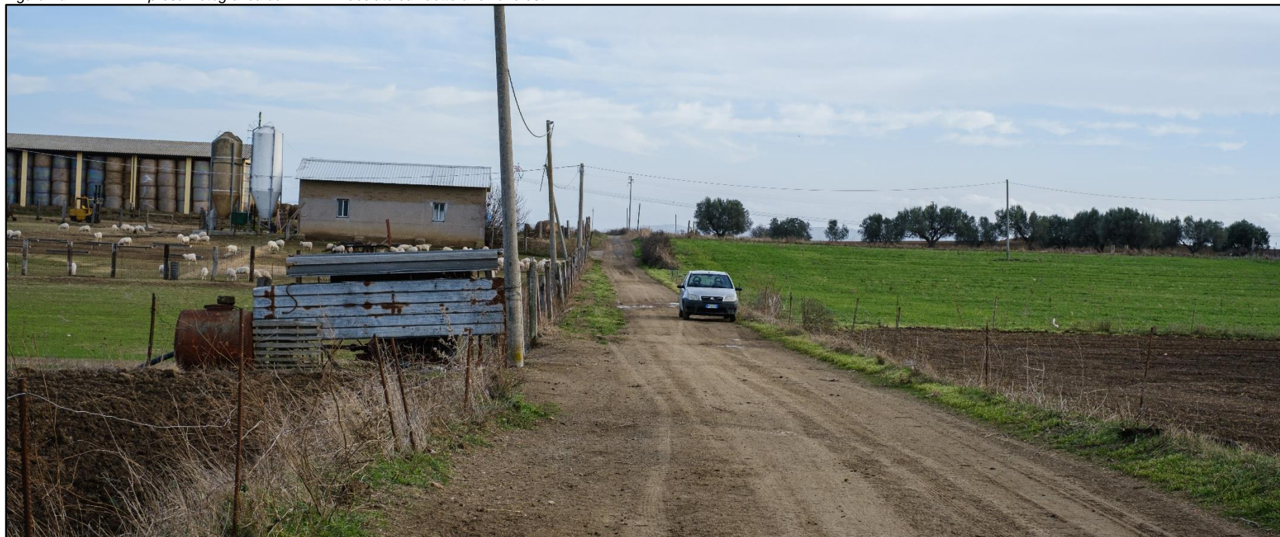
Figura 2d Ripresa Fotografica da PVD – Tracciato cavidotto direzione est
