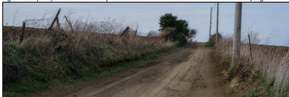
Figura 7.8c (1di3) Tratto di strada podereale esistente interessata dal cavidotto AT in progetto
