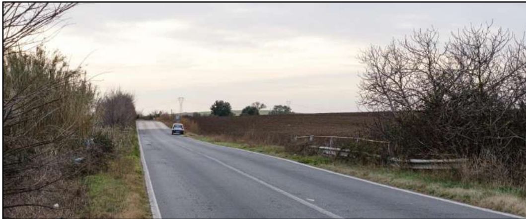
Figura 2.3.2m Tracciato cavidotto AT di collegamento tra l'impianto e la nuova sezione della SE "Tuscania" – Tratto 2: SP3
