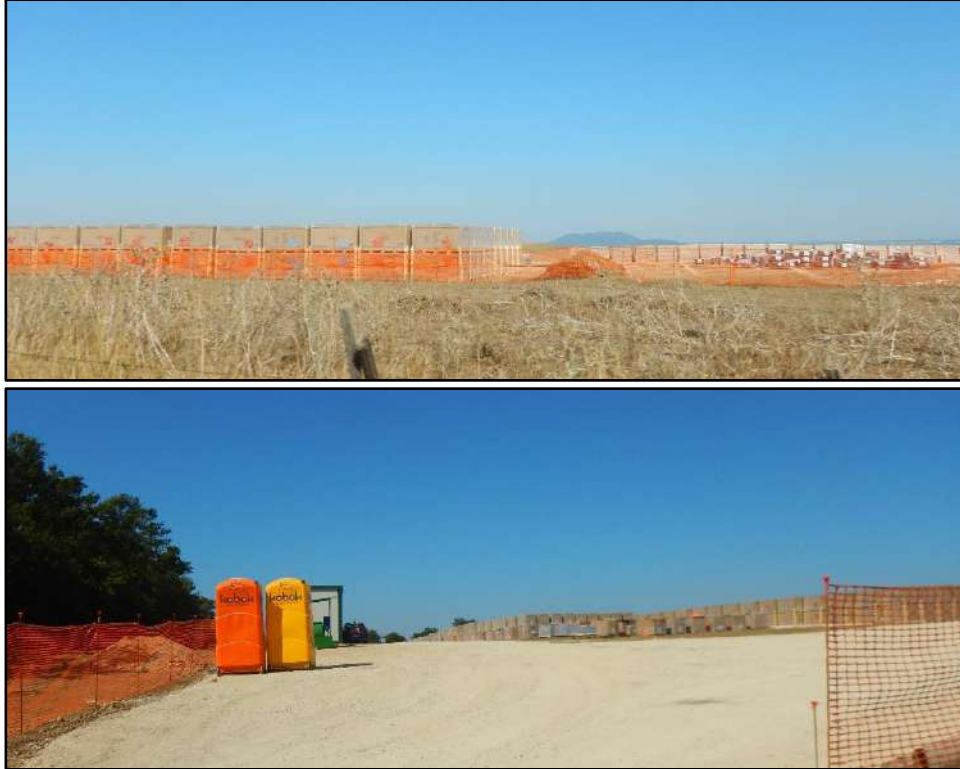
Figura 2.3.2g Aree cantiere impianto fotovoltaico
