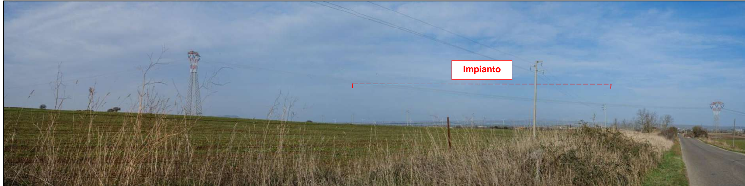
Figura 4.2.2.1e Ripresa fotografica da PV 4
