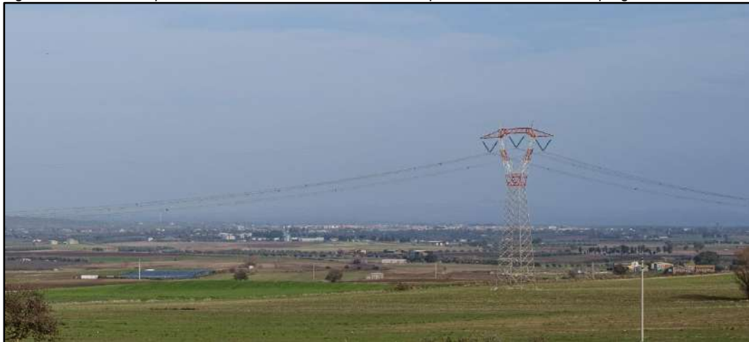
Figura 2.3.2f Impianto fotovoltaico e linea elettrica aerea presenti a Sud del sito di progetto
