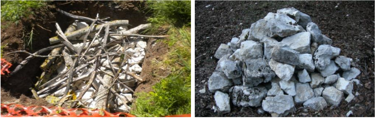
Figura 16. Le diverse fasi di realizzazione di un rifugio interrato per piccoli animali terricoli. Si tratta di una delle mitigazioni più efficaci per garantire habitat alternativi nei casi di spietramento a fini agronomici o, per il Progetto Agrivoltaico per il livellamento dei terreni e le quadrature di posizionamento dei pannelli.
