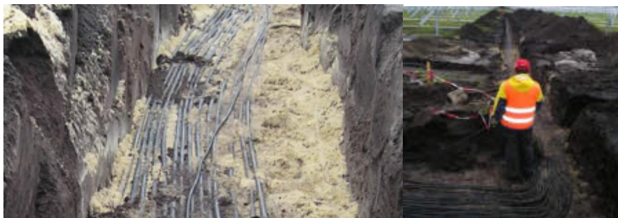
Figura 7: Conduttori CA (lato BT)
