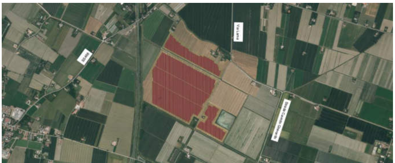
Figura 7: Accesso alle aree di impianto
