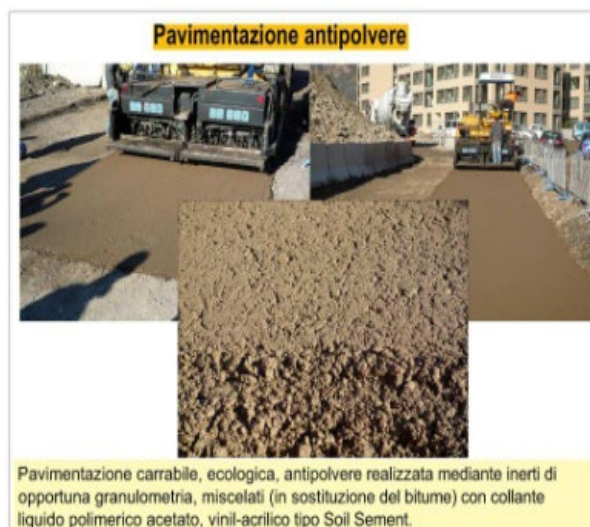
Figura 11-2: Pavimentazione carrabile ecologica
