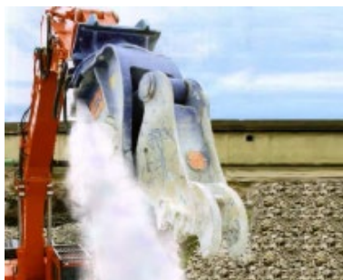
Figura 11-4: Nebulizzatore per escavatore con pinza demolitrice
