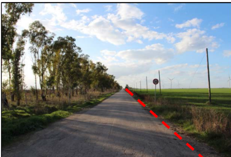
S.P. 70_cavidotto di collegamento
