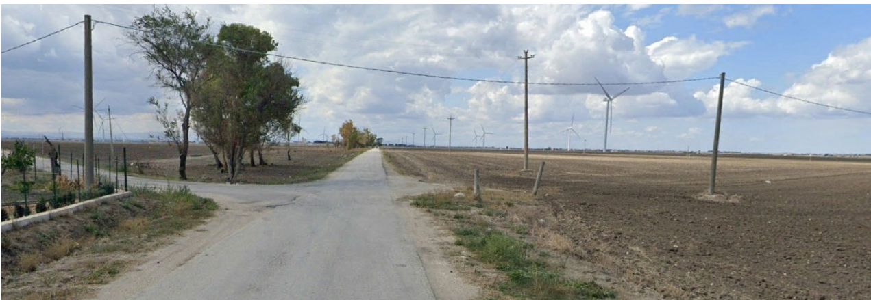
Linea elettrica bt
