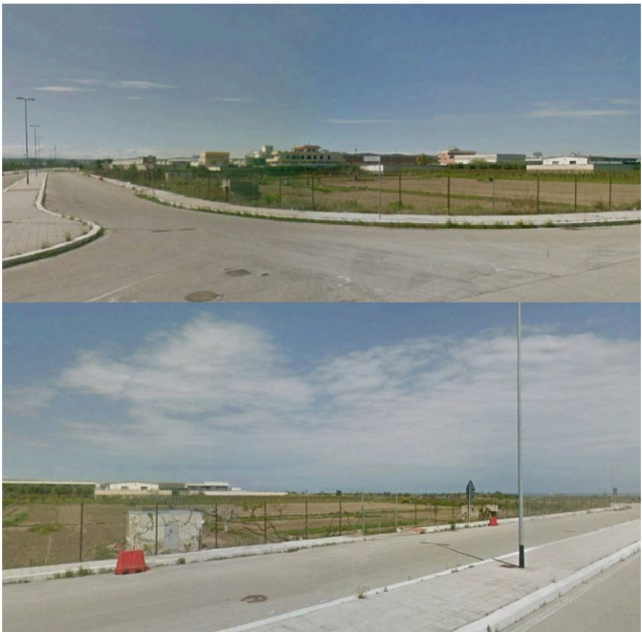
Rilievo fotografico dell'area di progetto della stazione di rifasamento
