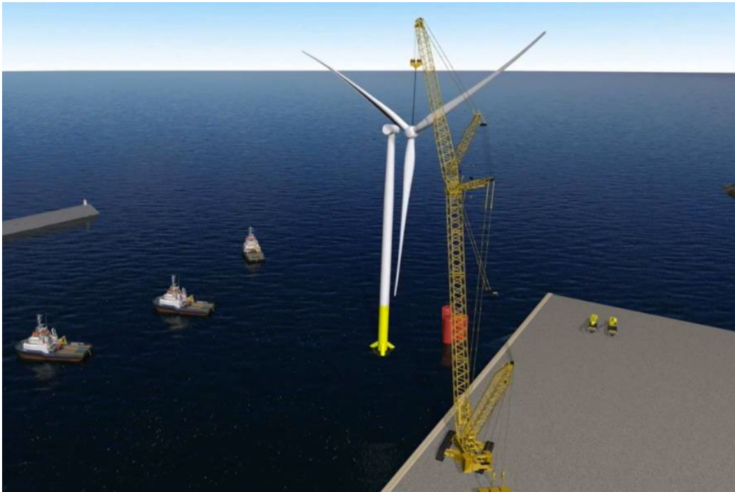
Montaggio di un aerogeneratore in banchina
