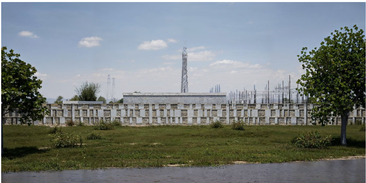
La sottostazione elettrica isolata in aria, rendering degli interventi di schermatura visuale
