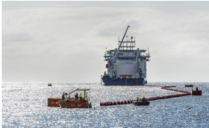
Posa del cavo in corrispondenza del punto di approdo
