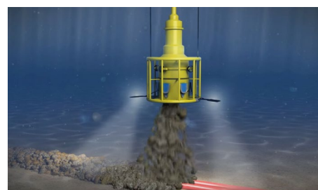
Sistemi di protezione dei cavi poggiati sul fondale mediante gusci di ghisa, materassi o rocce
