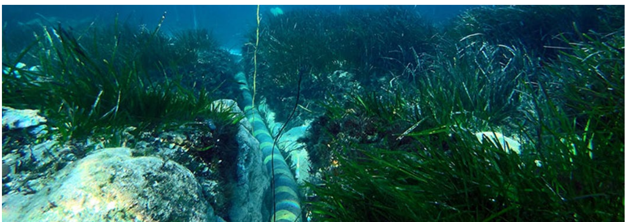
Esempi di esecuzione del trenching chirurgico
