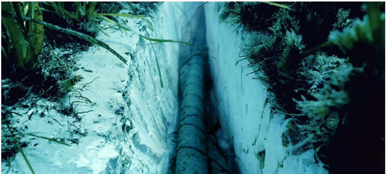
Il trenching chirurgico – esecuzione con aratro a pilotaggio manuale
