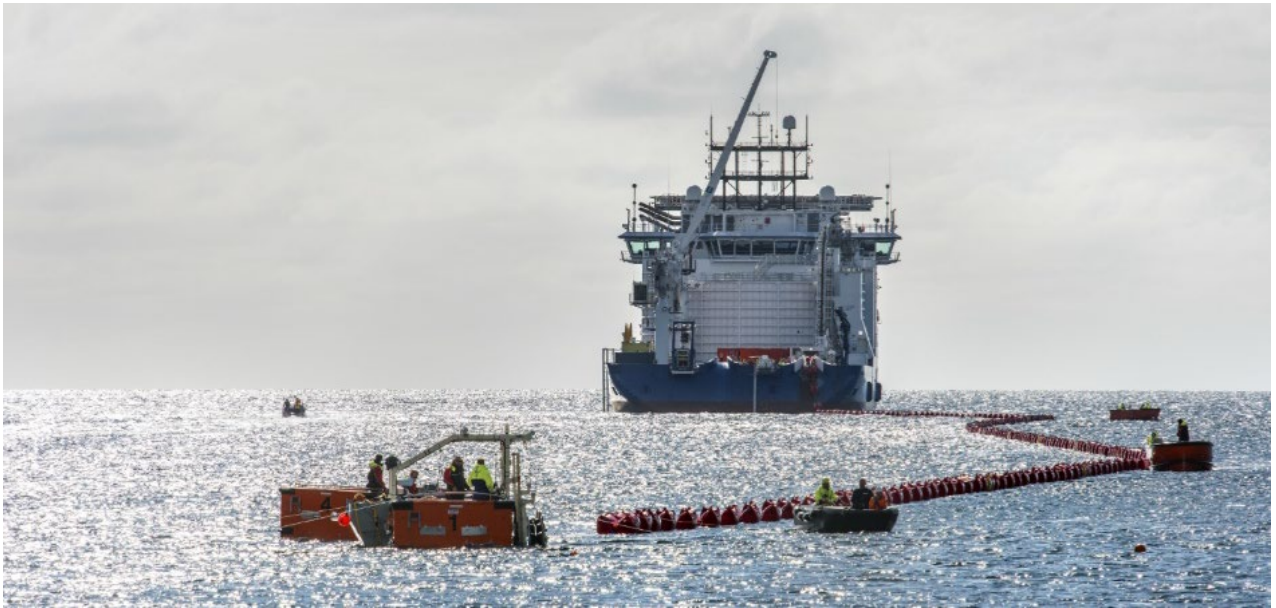
Posa del cavo in corrispondenza del punto di approdo
