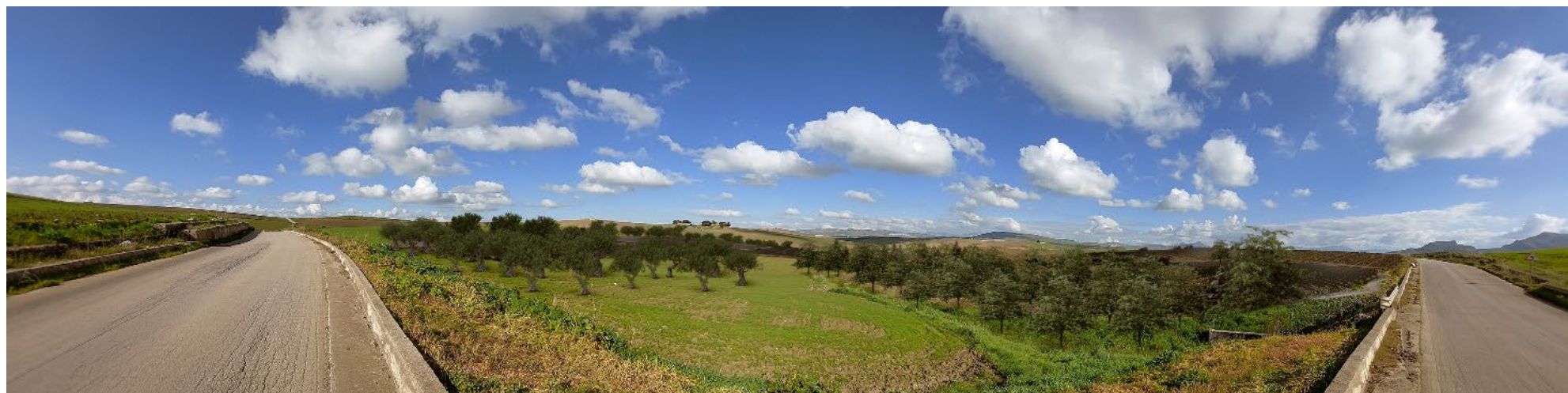
Figura 4 Punto di Ripresa 1 - post opera
