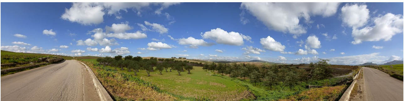
Figura 5 Panoramica da Bivio SP12
