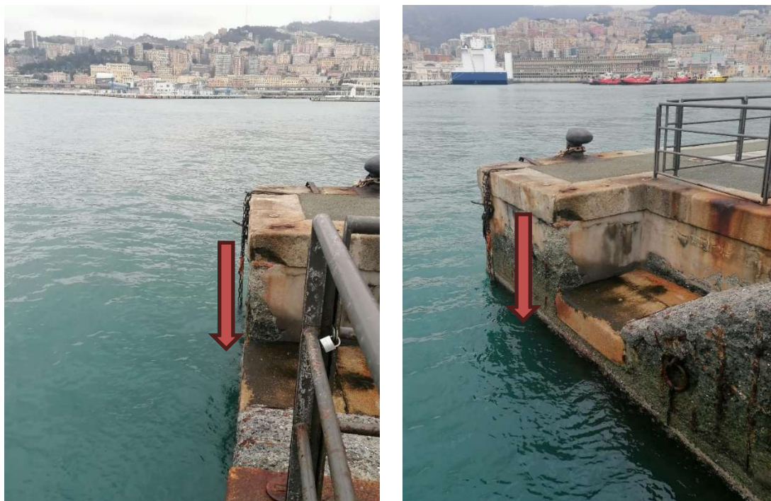
Figura 5.5 – sopralluogo della postazione MM02bis (evidenziata la posizione della strumentazione)
