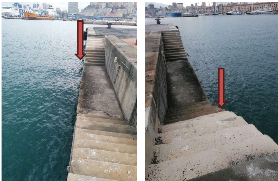
Figura 5.3 – sopralluogo della postazione MM03bis (evidenziata la posizione della strumentazione)
