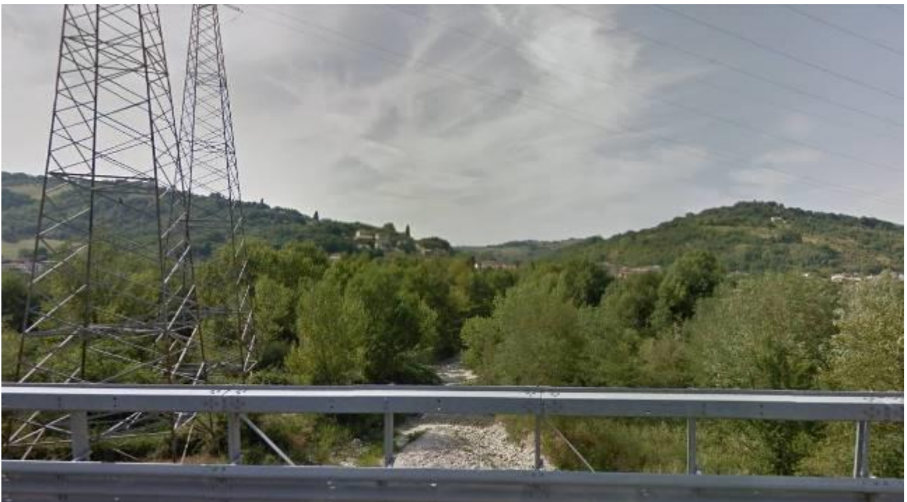
FIGURA 32 ATTRAVERSAMENTO DEL TORRENTE ESINANTE LUNGO LA SS 76 COMUNE DI SERRA SAN QUIRICO
