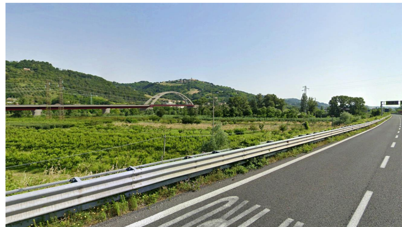
POST OPERAM CON PONTE CHIARO
