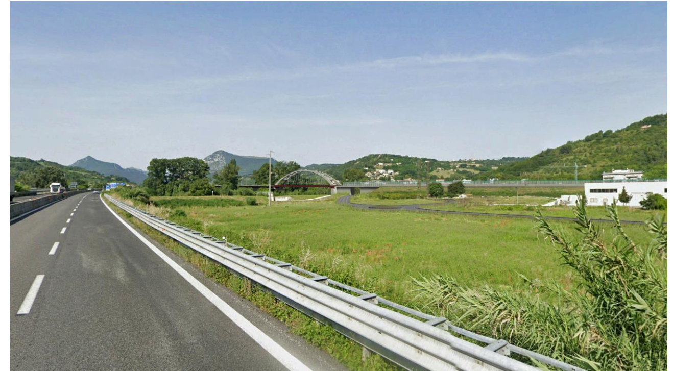
POST OPERAM CON PONTE CHIARO
