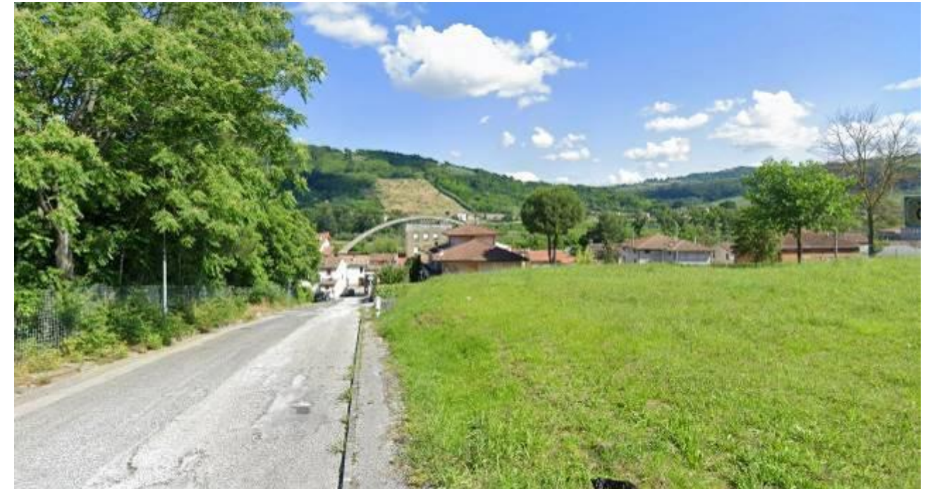
POST OPERAM CON PONTE CHIARO
