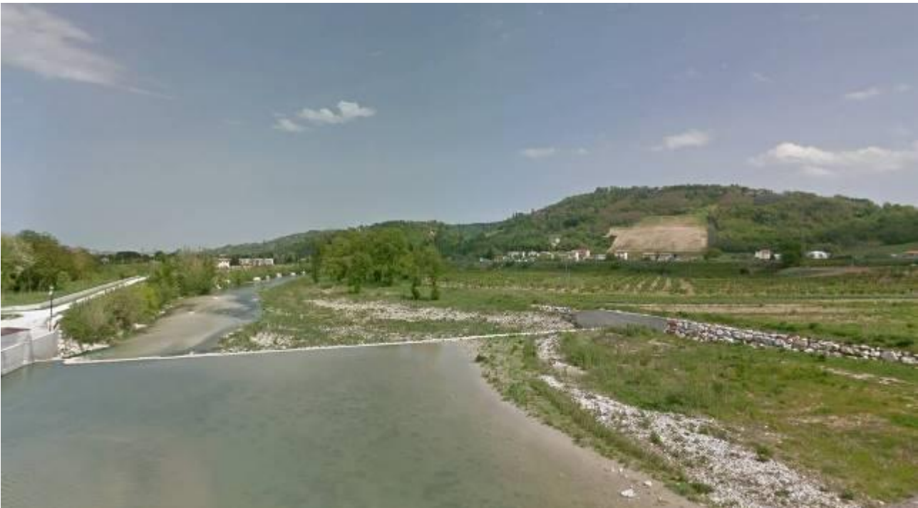
FIGURA 81 ATTRAVERSAMENTO DELL'ESINO AL CONFINE TRA IL TERRITORIO DEI COMUNI DI MERGO E CUPRAMONTANA DAL PONTE LUNGO LA SP9
