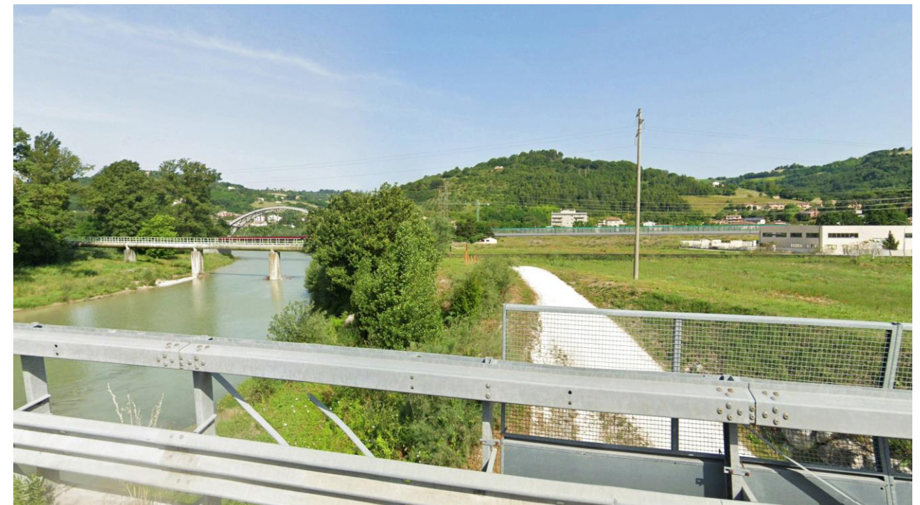
POST OPERAM CON PONTE CHIARO
