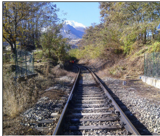
Impianto lubrificazione P.A.L. Italia (Foto: P.A.L. Italia; 2012)
