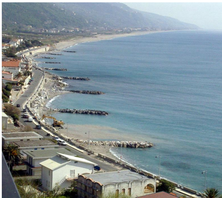
Figura 3.28. Tratta costiera in prossimità di Paola
