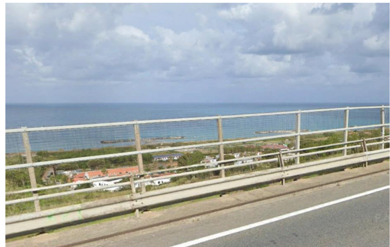
Figura 4.11. Vista della S.S. 18 in direzione dell'area costiera
