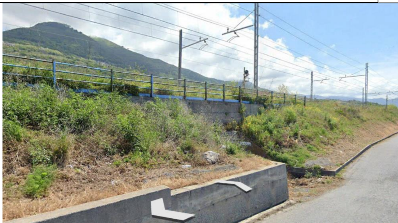
Figura 4.12. Fascia di mascheramento (rilevato ferrovia attuale) per le aree di cantiere prospicienti la costa
