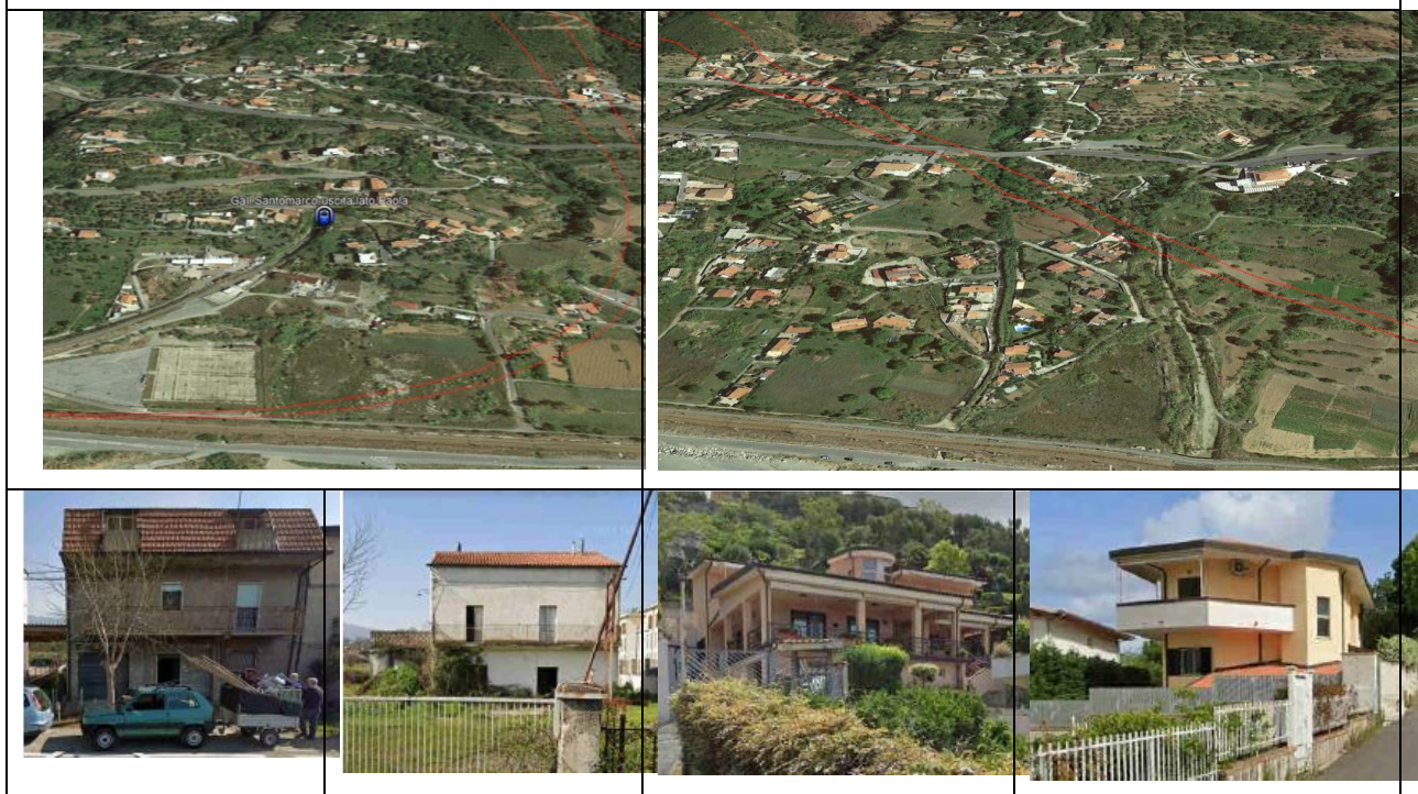
Figura 3-4 Tratto all'aperto Lato Paola, e tipologie costruttive: rilievo fotografico
