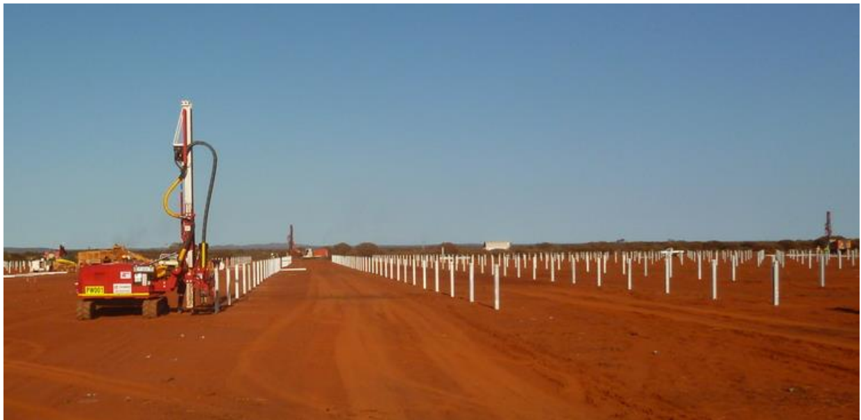
Figura 59: Infissione sostegni a mezzo di battipalo
