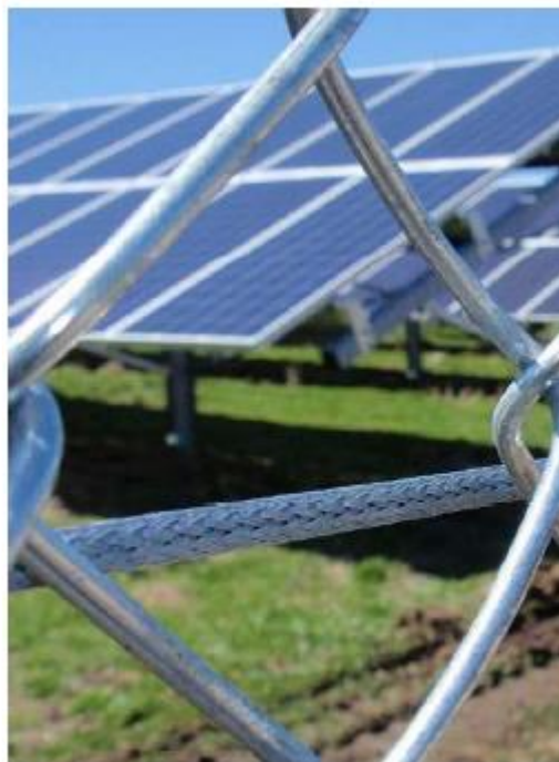
Cavo in fibra ottica montato su rete metallica.
