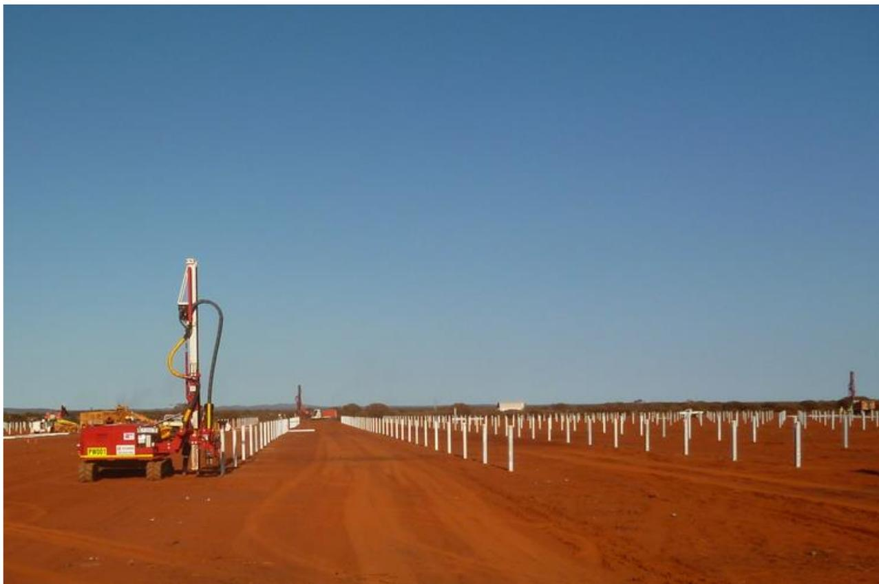
**Figura 38: Dettaglio posizionamento pali**
