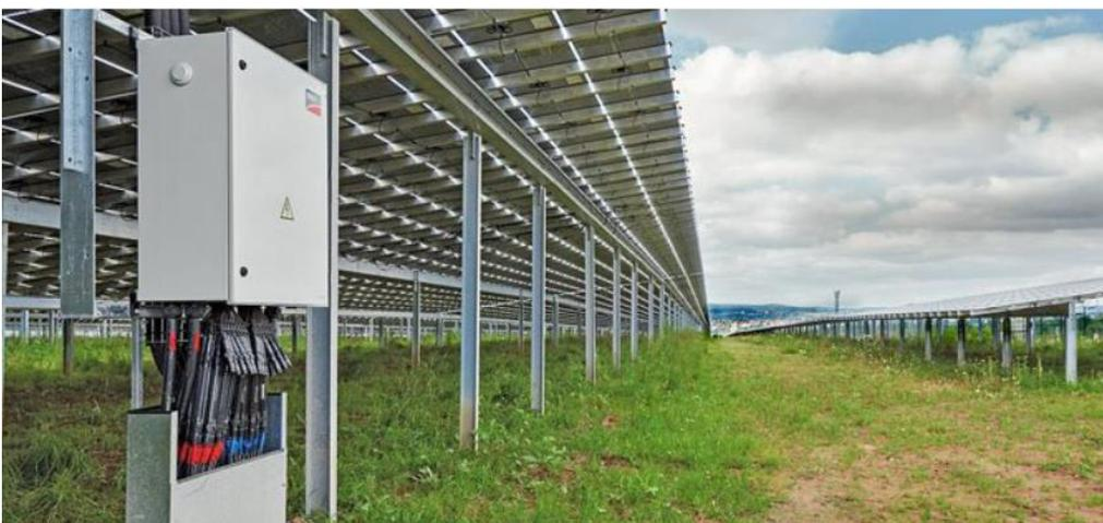
Figura 6 - Esempio di string combiner SMA
