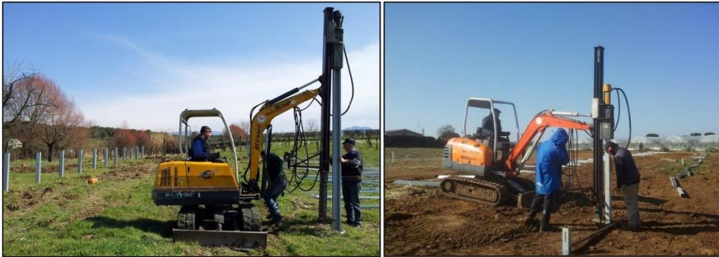
Figura 53 - Tipologia di installazione delle strutture di sostegno dei moduli FTV con macchina battipalo
